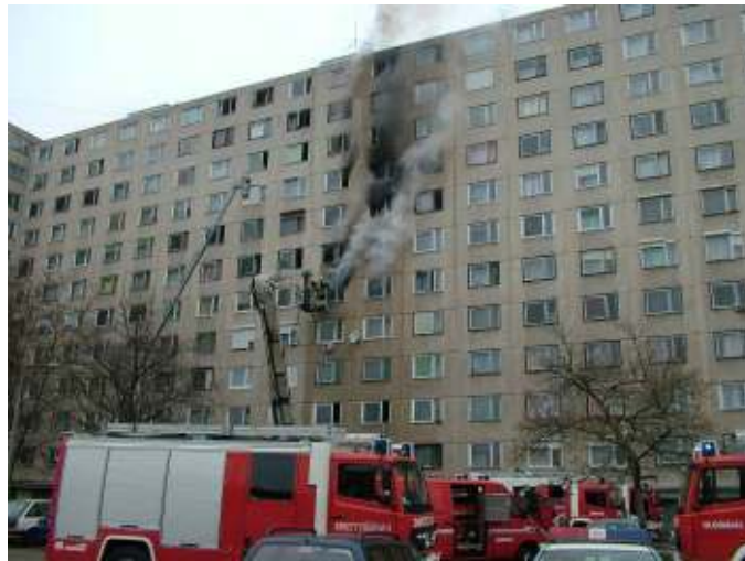
1. A déli homlokzat összképe tűzoltás közben (fotó: Debreceni Hivatásos Önkormányzati Tűzoltóparancsnokság)
