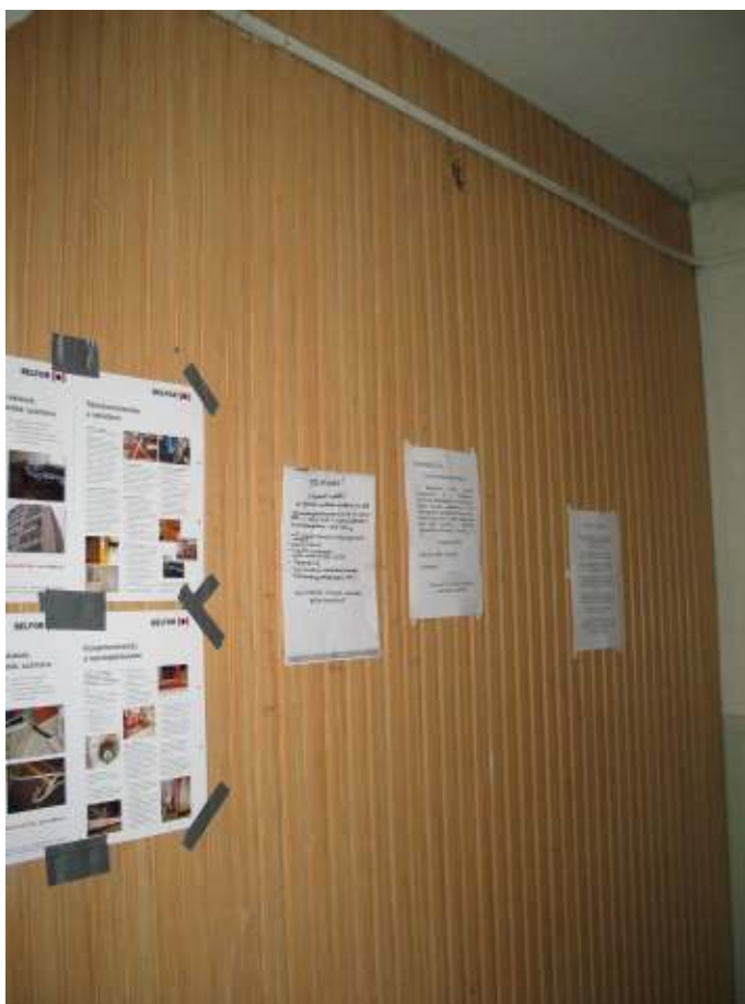
19. Éghető falburkolat alkalmazása a lépcsőház földszintjén (fotó: Király András)
