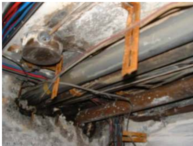
13. Az elektromos felszállók belső képe a födémek síkjában készült kibetonozással (fotó: Takács Lajos Gábor)
