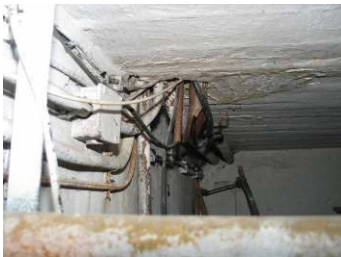
20. Elektromos vezetékháttörés a pincszinti födémen (fotó: Király András)
