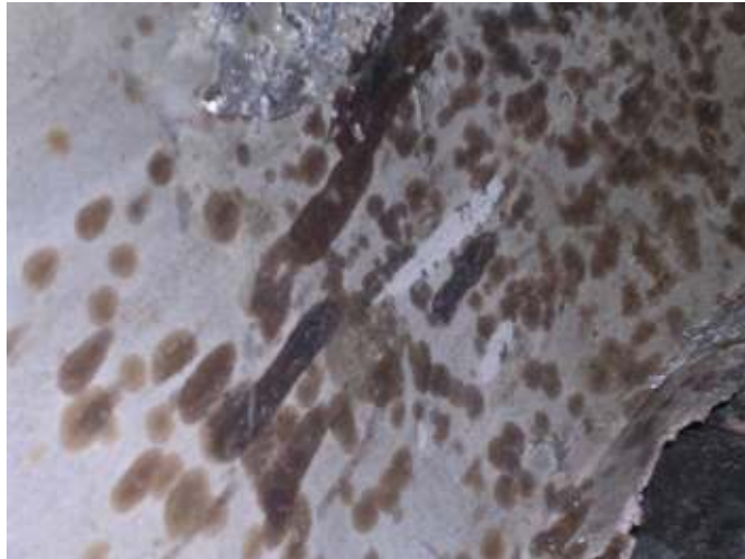
7. A konyhai szagelszívó mellékcsatornás gyűjtőcsövének közelképe... (fotó: Szikra Csaba)
