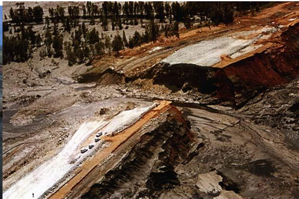
1 Rotura de la presa de la balsa que contenía los residuos tóxicos en la mina de Aznalcollar, el día del vertido.
