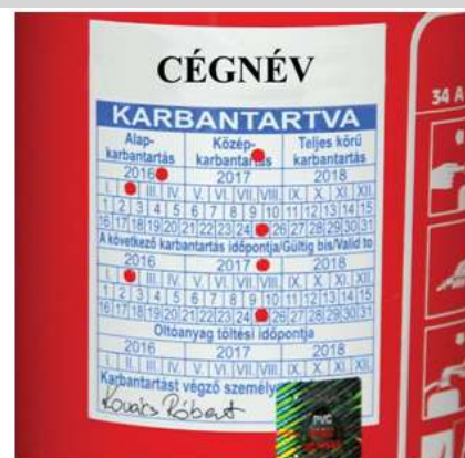
Karbantartást igazoló címke felhelyezése OKF azonosító jellel
