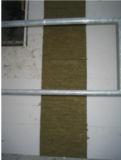
Tűzvédelmi célú kőzetgyapot sáv kialakítása.
