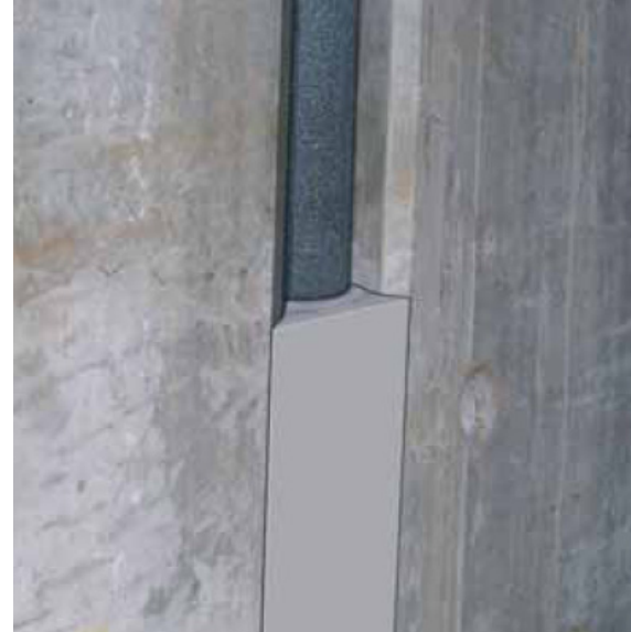
31. ábra Dilatáció, hézag lefedések
