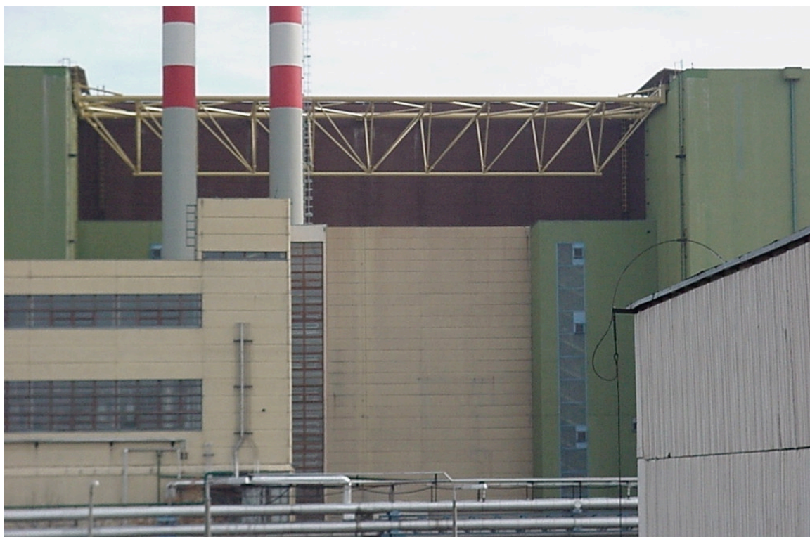
2. ábra. Hídszerkezet a lokalizációs tornyok között
