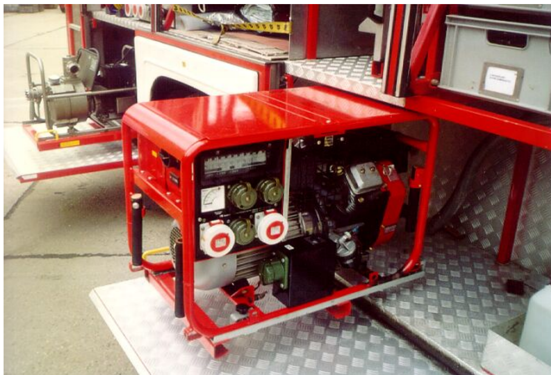
Hordozható 8 kVA aggregát, azoknak az elhárítási helyeknek az energia megtáplására, ahova a vegyi elhárító gépjármű nem tud bejutni
