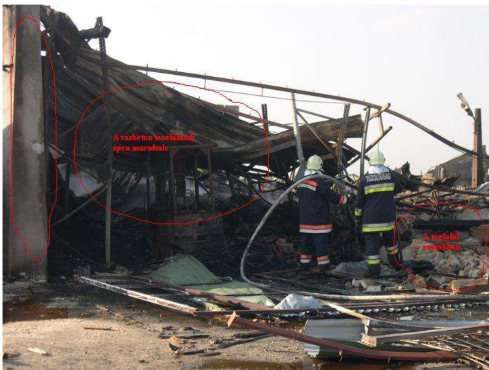
2.sz. kép: Az elpusztult raktárépület (piros színnel jelölve a vasbeton támfal és az összeomlott téglafal)
