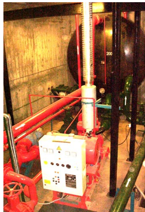
1 db villanymotoros és 1 db diesel meghajtású szivattyú
