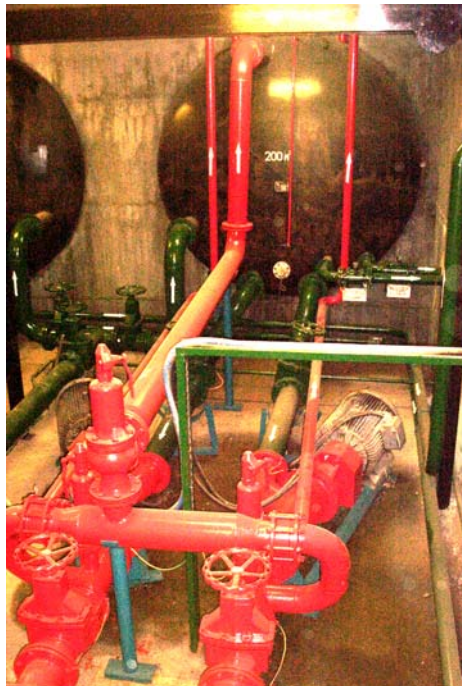
2 db villanymotorral hajtott szivattyú
