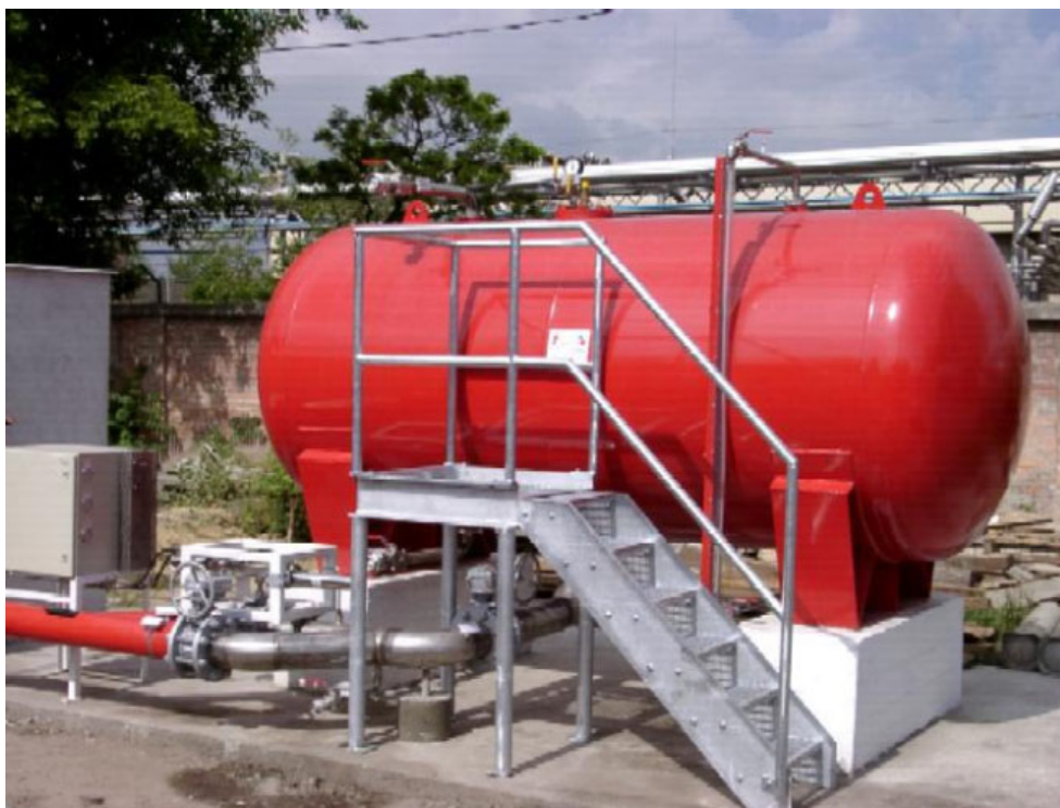
21. kép: Az Újpesti Erőmű oltóberendezésének automatikus szelepei és habtartálya
