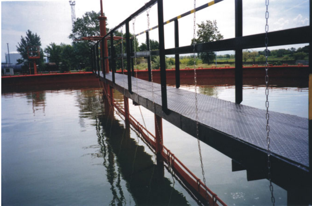
9. kép: Acélszerkezetű kezelőjárda a tartályba építve
