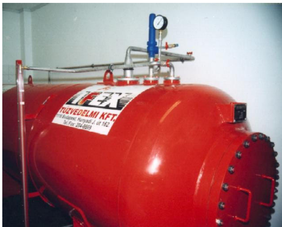
28. kép: Futó utcai oltóberendezés habellátása
