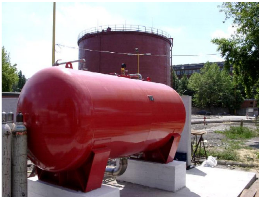
22. kép: Az Újpest Erőmű 5 000m 3 -es kerozin tartályának habellátó rendszere
