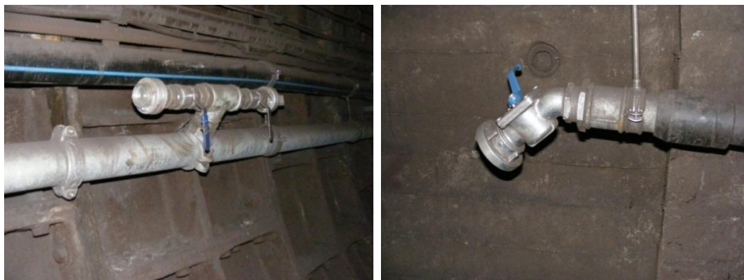
7. és 8. kép: Az alagútban kiépített tűzivízvezeték csatlakozási pontjai (forrás: saját fotó)
