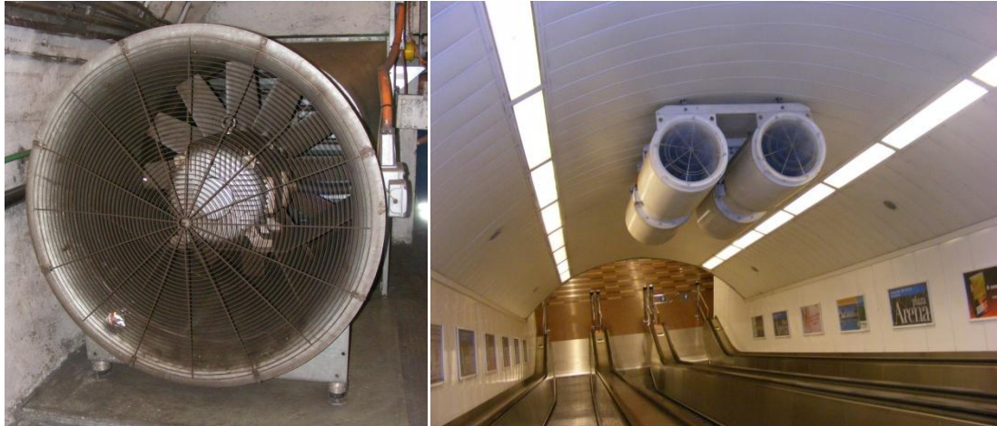
3. és 4. kép: Balra a Keleti Pályaudvar és a Stadionok állomások között található egyik vonali főszellőző ventilátor, jobbra a mozgólépcső lejtaknájába épített sugárventilátorok a Keleti Pályaudvarnál (forrás: saját fotók)
