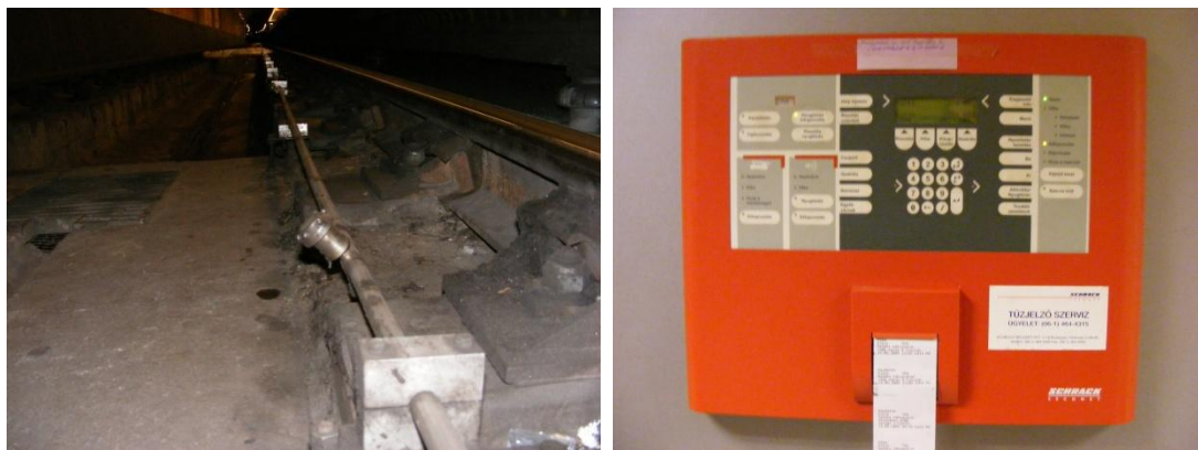
1. és 2. kép: Balra a peronok mentén végighúzódo vízköddel oltó rendszer szórófejei, jobbra a tűzjelző hálózat kezelőfelülete (forrás: saját fotók)
