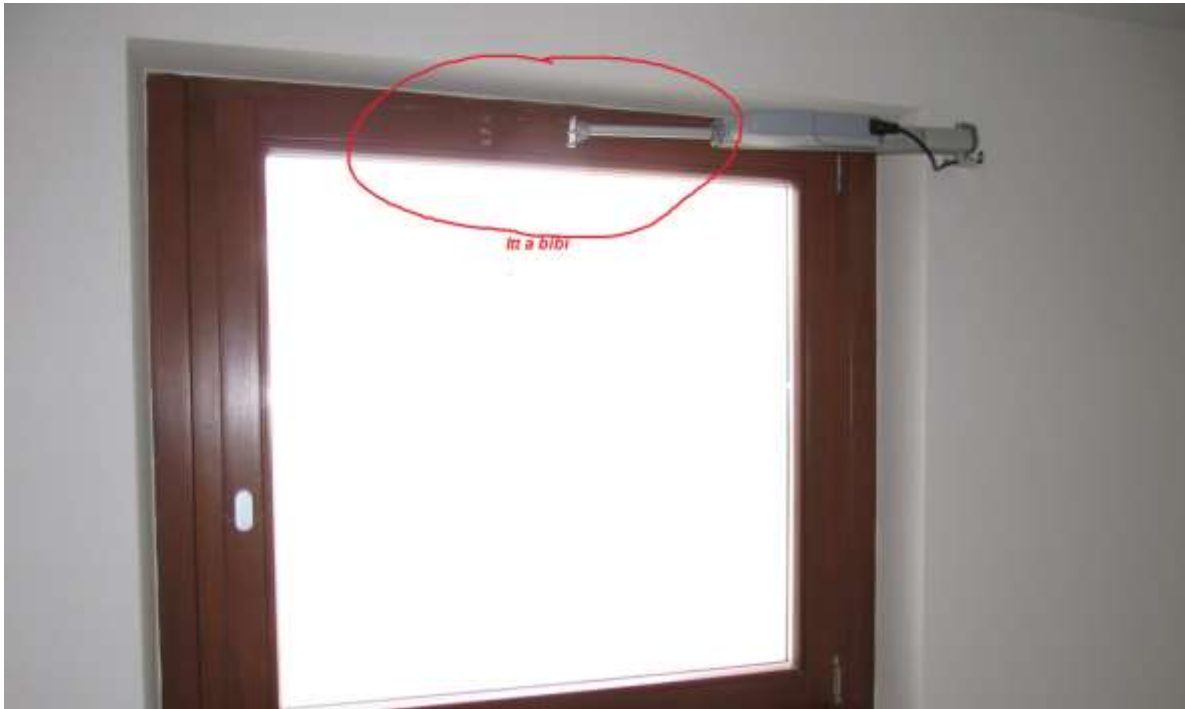
1. kép Ablak + motor így nem hő- és füstelvezető – motor nyaka leszakadt a tokozatról, nem működik Füstelvezetés szempontjából jobbnak tűnik a 2. képen lévő megoldás, hiszen itt nem a nyitással, hanem a záródással van a probléma. A normál ablak zsanérozása nem bírja a pluszterhelést és igénybevételt. Más kérdés, hogy a hőre itt sem gondoltak, így a nyitással is gondok lehetnek. A hő- és füstelvezető rendszer alapelemének számító elektromos vezetékek nem alak- és funkciótartóak, hő hatásra tönkremennének.
