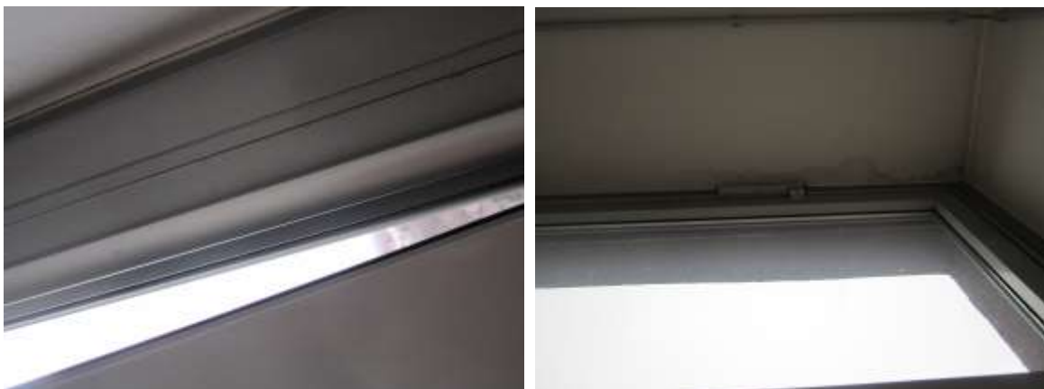
3. kép Füstelvezetésre szánt ablak, zárva és nyitva. Ezen lényegében semmi füst nem megy ki.
