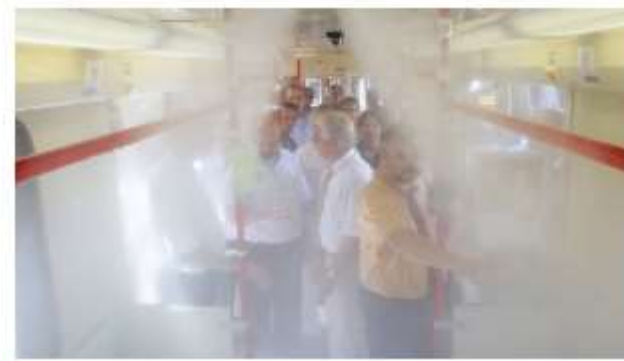
2. sz. kép: Gyorsvasúti kocsiba telepített vízködös oltórendszer működés közben (forrás: [7])
