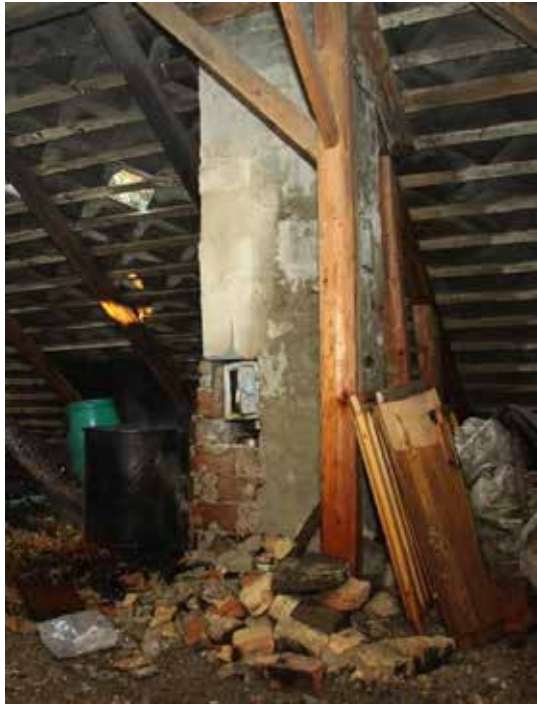
Padláson a kémény következtében keletkezett tűz
