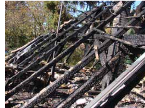
Beégés nyomok mélységének változása a szarufákon
