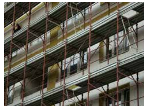
Homlokzati tűzterjedés elleni gátak
