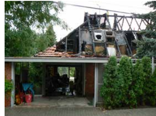
Tetőtéri lakásban, elektromos energia gyújtóhatása miatt keletkezett tűz terjedésének képe
