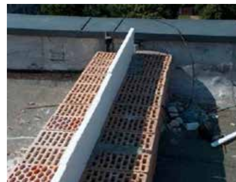
Tetőszinti tűzterjedés elleni gátak
