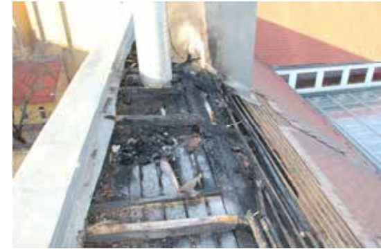
Építési hiba következtében keletkezett tűz
