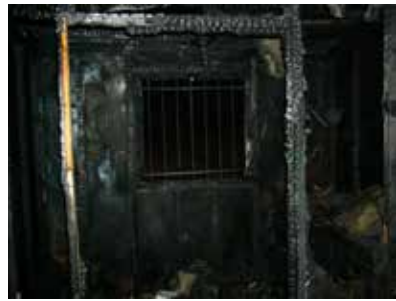
6. kép A két függőleges irányú fa szerkezet a szoba és az előtér helyiségek között húzódó válaszfal tartó szerkezete. A baloldalon a bejárati ajtó felé látható a nagyobb fokú szenesedés.
