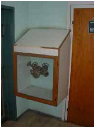
Száraz felszálló vezeték
