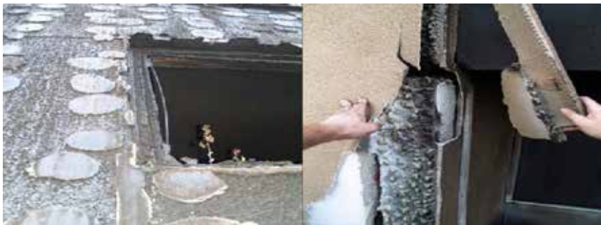
Szakszerűtlen homlokzati hőszigetelés
