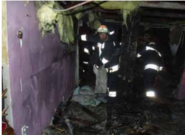
Hőszigetelő anyag károsodása
