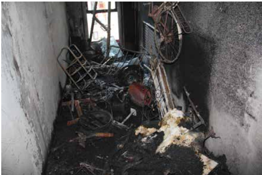
Közeledő szakaszban történt tüzeset égésmaradványai
