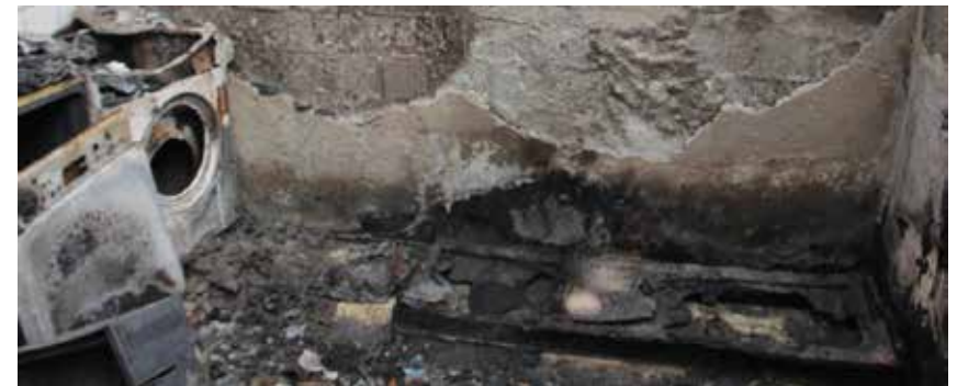
1-2. kép. a tűzfűszkének fotója megváltoztatás nélkül és megtisztítás után
