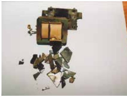
Villámcsapás hatására a szomszéd kapucengőjének trafója szétrobbant. (Impulzus jellegű elektromágneses hatás)
