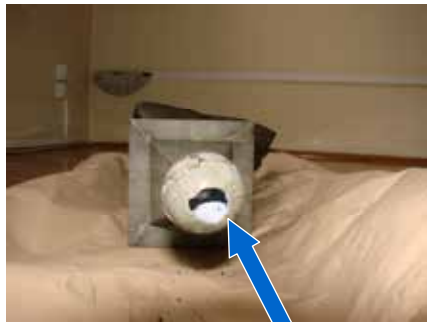
Vonalvillám tető-csúcsdíszbe csapott bele (Hőhatás miatt lyukképződés)
