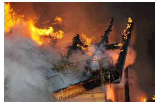
Nádfedésű tetőszerkezet tüze
