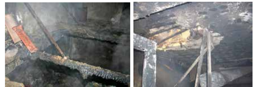
Födém felületfolytonosságának megszakadása
