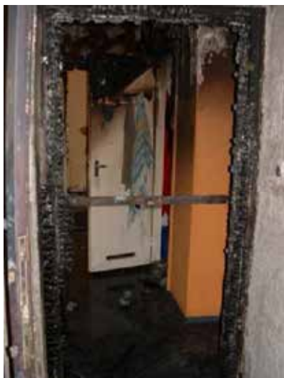
Nem megfelelő tűzállóságú bejárati ajtó
