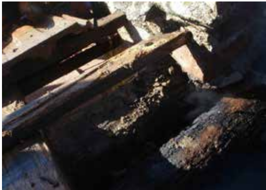
Építési hiba következtében keletkezett tűz
