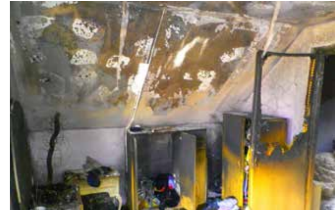
A rétegelt felépítésű gipszkarton szerkezet rétegei közti tűzterjedés, a felületfolytonos kialakítás hiányosságai miatt, valamint a felület károsodása
