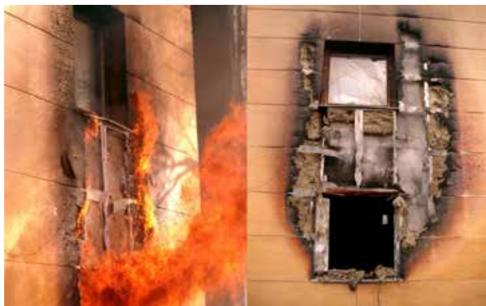
Tűz terjedése a homlokzaton
