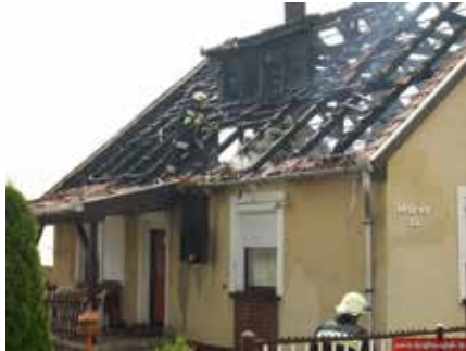
A villanyóra szekrényben keletkezett tűz az ereszen keresztül terjedt a tetőszerkezetre
