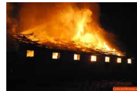
Acél tetőszerkezet tüze, a szerkezet deformálódásával végződött
