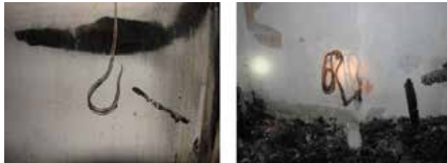
Kiegészített szaunában talált elektromos vezetékek
