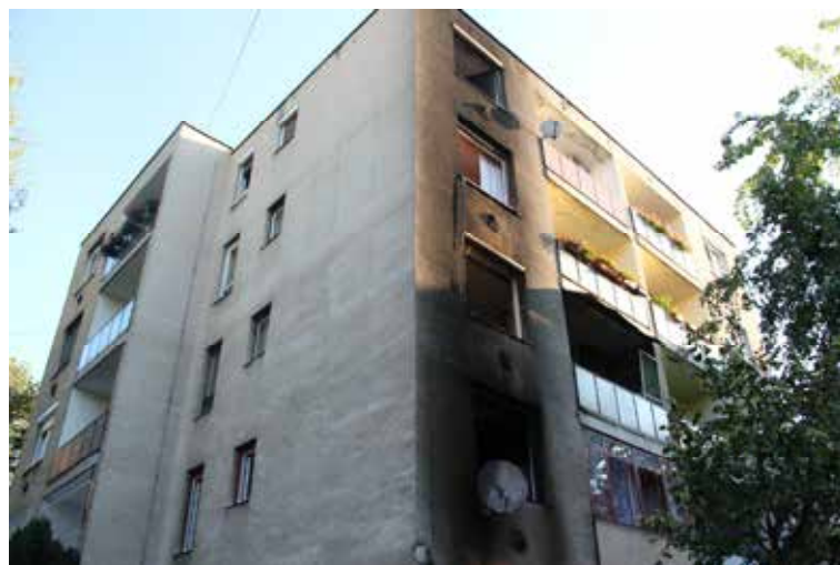
Nem éghető anyagú homlokzat károsodása
