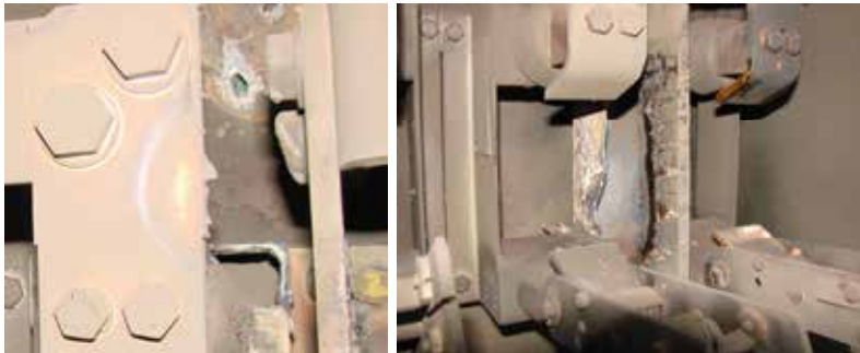
Rövidzárlati ív okozta olvadásnyomok az egyik budapesti villamos nagyfeszültségű felsővezetékéhez tartozó kapcsolószekrényben
