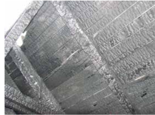
A taréjszelemen irányába haladó egyre mélyebb, intenzívebb beégés nyomok
