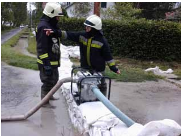
Szivattyúzási munkálatok a Balatoni áradásnál (2014)
