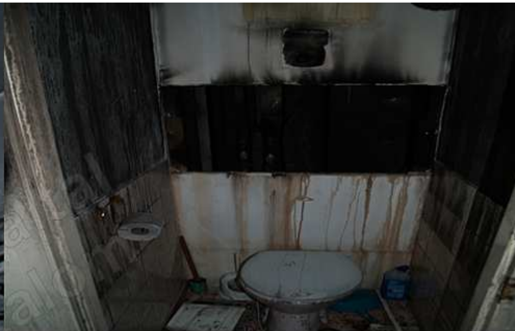
WC füstszivárgás tűz után Szellőzővezeték poros lerakódás
