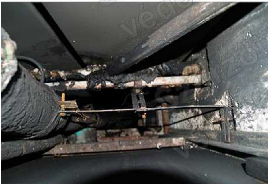
Csapadékvíz vezeték földémcsatlakozása Akna belső
