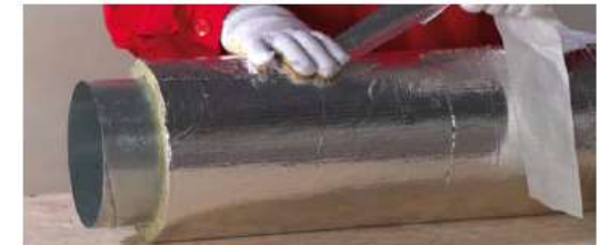
Uszczelnienie taśmą aluminiową połączeń podłużnych i poprzecznych.
