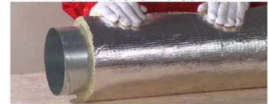
Owinięcie kanału izolacją.
