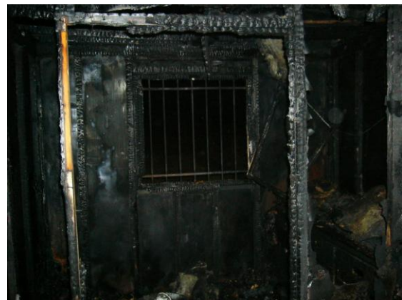
6. kép A két függőleges irányú fa szerkezet a szoba és az előtér helyiségek között húzódó válaszfal tartó szerkezete. A baloldalon a bejárati ajtó felé látható a nagyobb fokú szenesedés.
