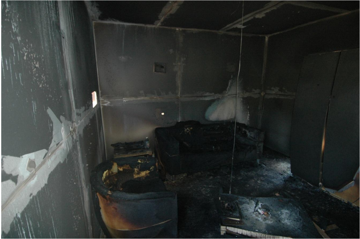
64.kép Tisztára égett falfelület az egykori kanapé jobb oldala felett. Az USA ATF tűzvizsgálóinak felvétele, ILEA oktatás keretében.
