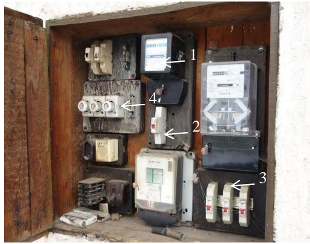
Mérőóra (1), főbiztosító (2), kismegszakítók (3), olvadó biztosítók (4)
