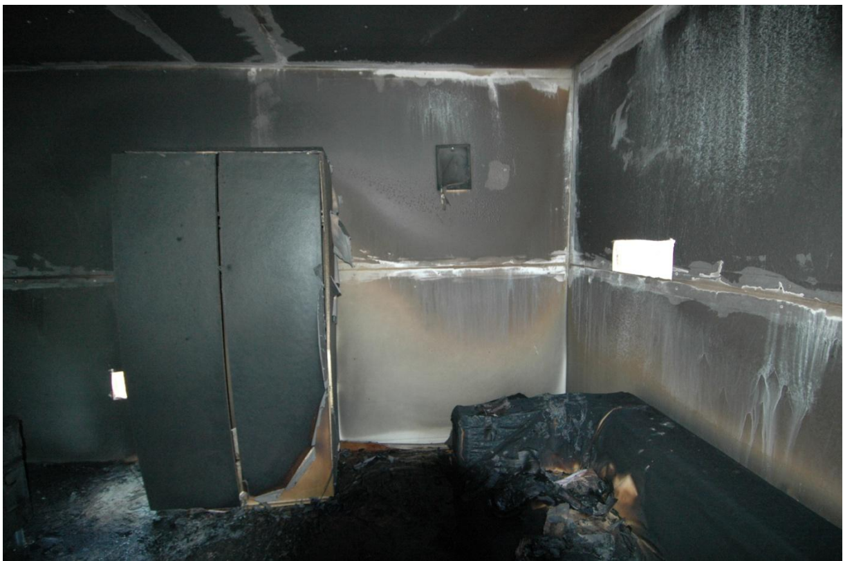
65. kép A szekrény jobb oldalán lényegesen gyengébb tűzzel érintettség látható, különösen alul. Az USA ATF tűzvizsgálóinak felvétele, ILEA oktatás keretében.
