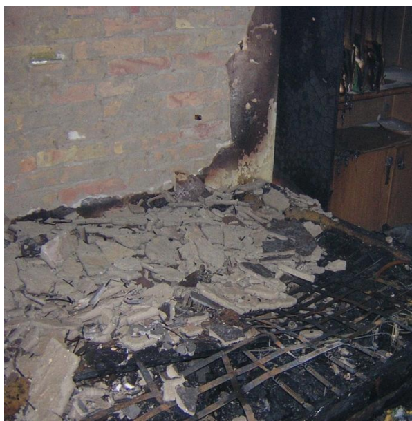
2. ábra Vakolatlehullás a tüzesetet követően
