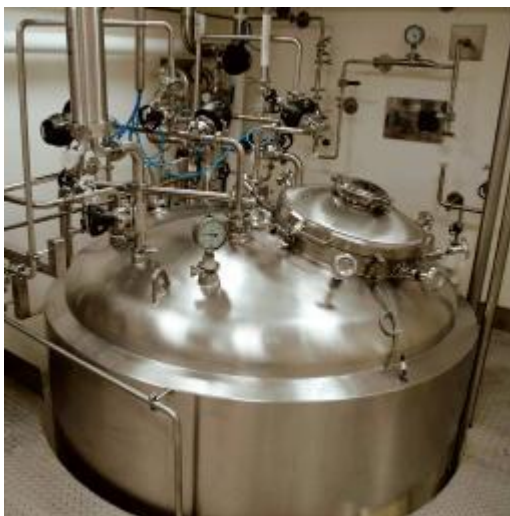
Tipikus vegyipari berendezés, szerelvényekkel
