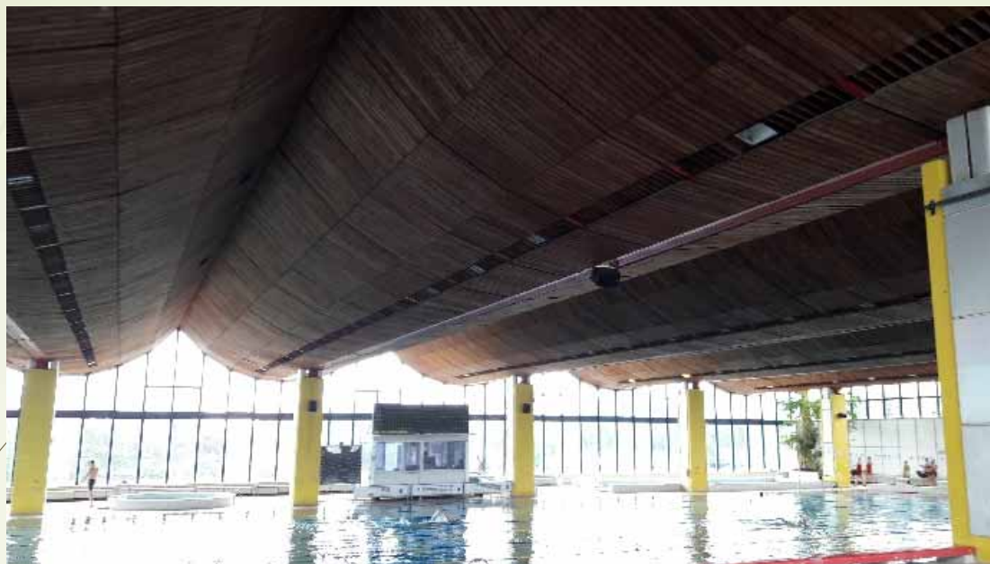
Uszoda rekonstrukciója, Szombathely
