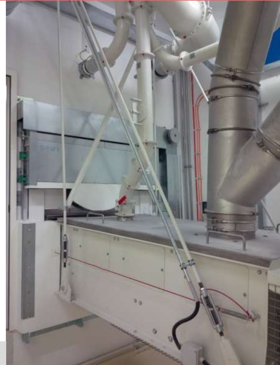
ECCLOS-S EI90 tűzgátló szállítószalag-lezárás
