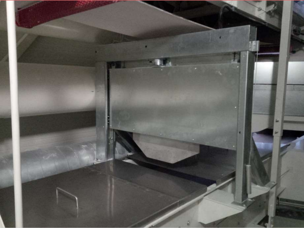
Mechanikus torlókapu tűzgátló szállítószalag-lezáráshoz
