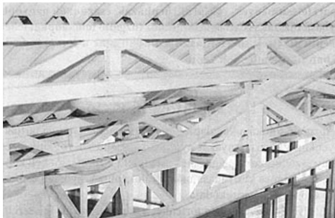
Tűzvédett acélszerkezet tűzállósági határérték 30 perc
