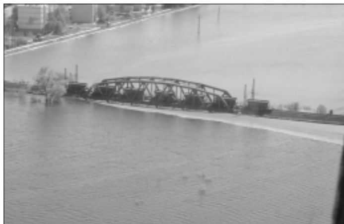
Vasúti hid leterhelése – Szolnok
