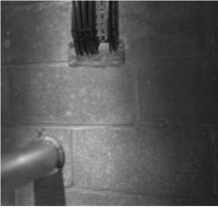
A Formázható kitt könnyen eltávolítható és újra felhasználható
