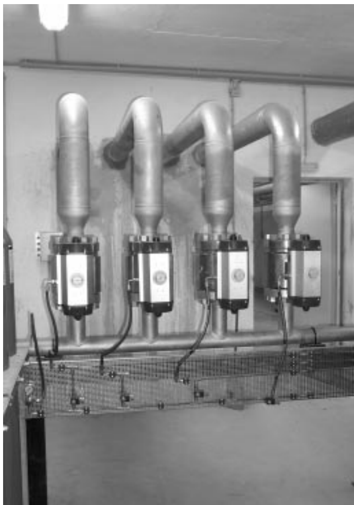
Beépített nyomáscsökkentők és elosztó szelepek
