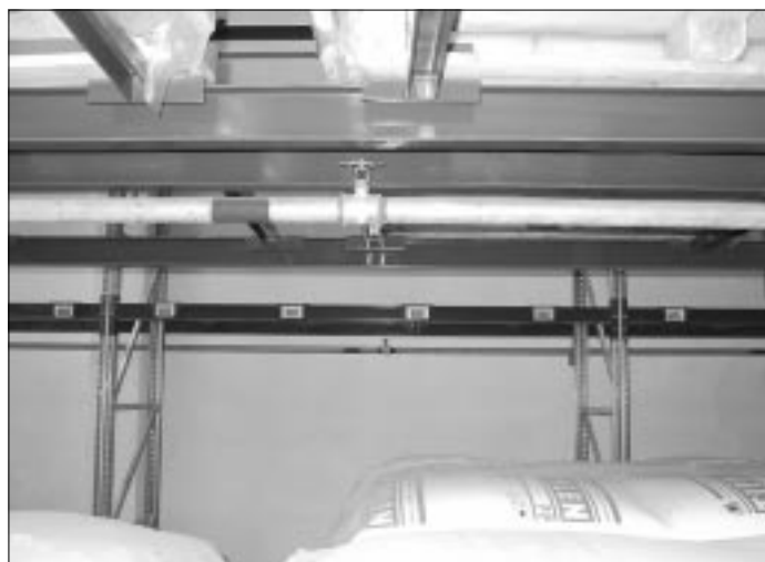
Száraz, elővezérelt spinkler
