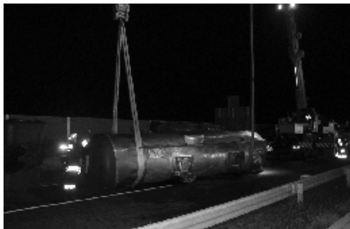
Emelés és fordítás két daruval
