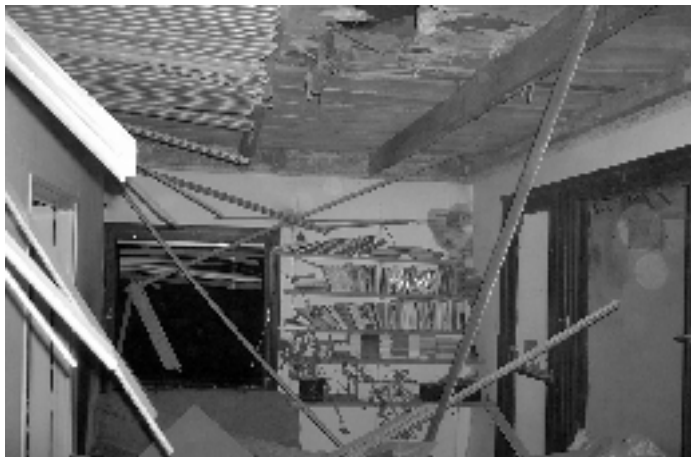
A mennyezeti lambéria „szétbontva”, ajtók, ablakok kimozdulva
