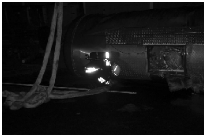
Kötél átfűzése a tartálypalást alatt
