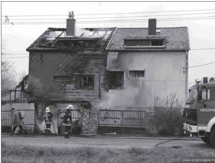
4. ábra. Vonalkód homlokzatképzési mód: a jogszabály helytelen értelmezésével, az ablaknyílások eltolásával próbálják kikerülni a tűzterjedési gátak megépítését
