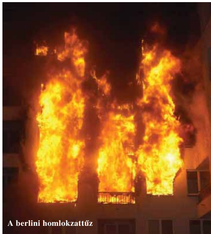
A hőszigetelő rendszer leomlása I.
