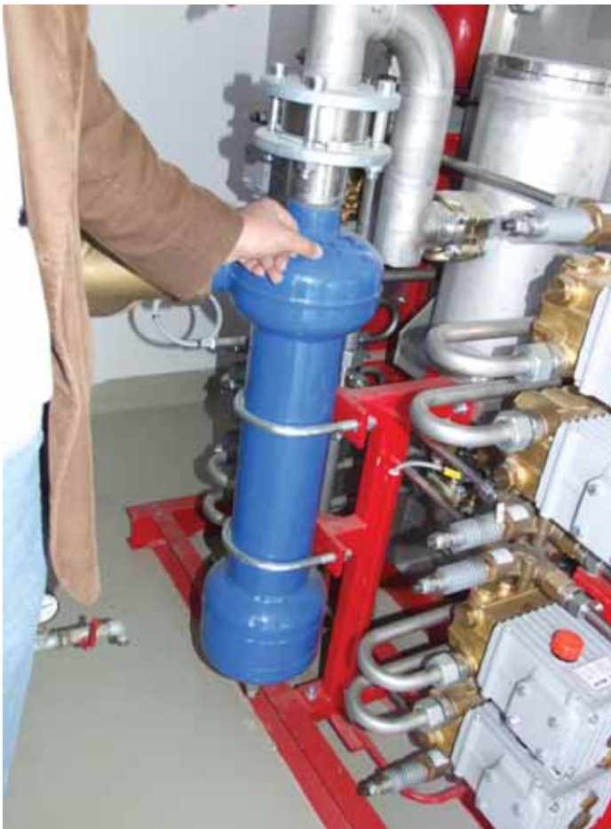
Csak szűrőn keresztül kerülhet víz az oltórendszerbe
