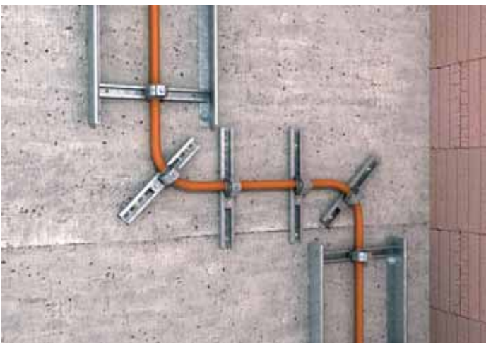
Felsőálló kábelrendszer kialakításánál lényeges, hogy legfeljebb 3,5 méterenként úgynevezett “hatásos alátámasztást” alakítsunk ki, például a képen látható módon. Ezek hiányában az égő kábel kicsúszna a bilincsek alól.
