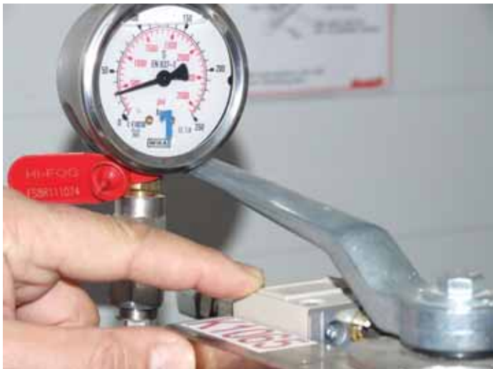
Az oltórendszer szabályozói számmal jelölve, állapotukat a tűzjelző rendszer mutatja
