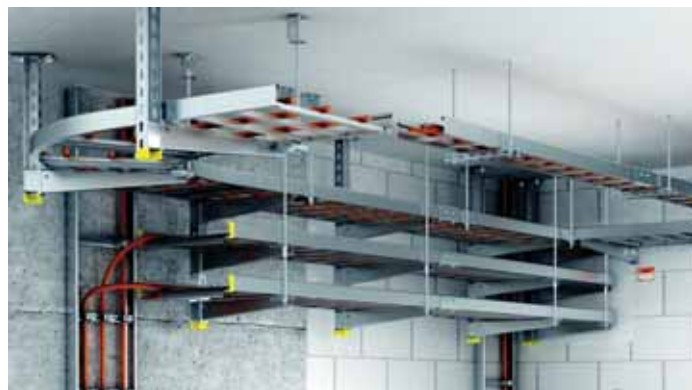
Kábeltrákból kialakított tűzálló kábelrendszer. A létrákat alátámasztó konzolok vége menetesszárral van biztosítva, hogy megakadályozzuk a hőterhelés hatására bekövetkező lehajlásukat.
