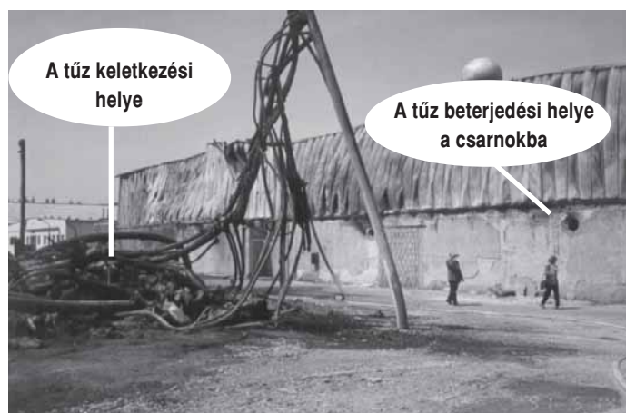
A szentgotthárdi üzem a ventilátor nyíláson becsapó lángoktól égett le
