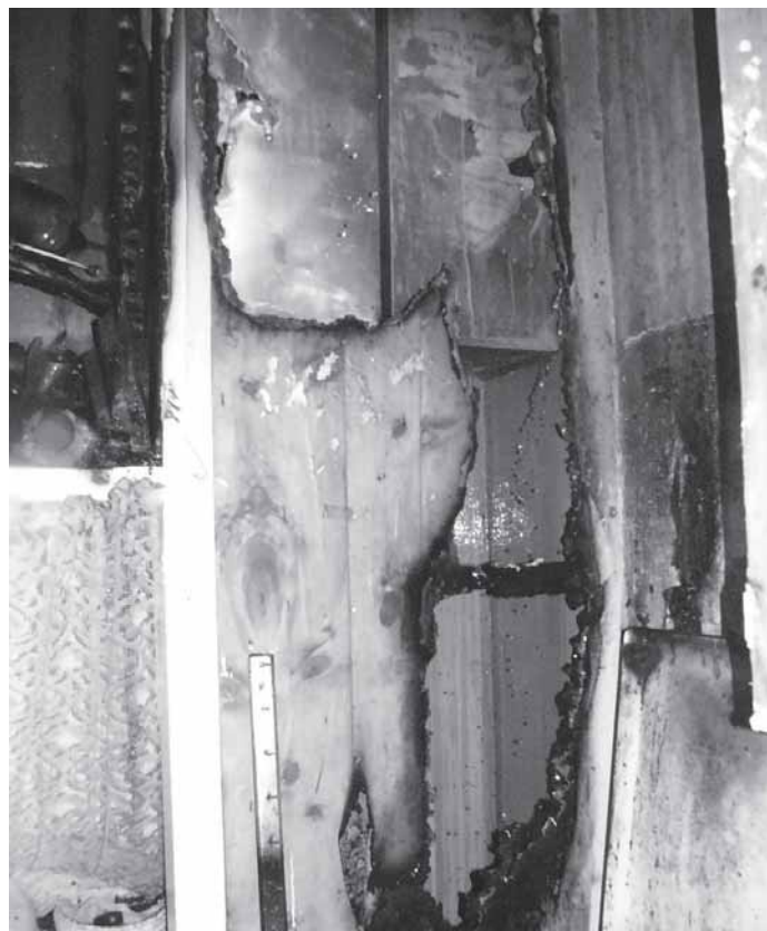
A Debreceni földszint 2 sz. lakás károsodott aknájának képe, V alakú beégés a tűzhely és a szellőző között
