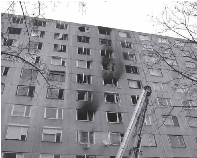
Az épület homlokzata a tűz után
