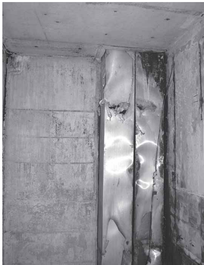
A Debrecen, Fényes udvar 6 sz. alatti épület X. emeleti konyhájának belső képe a tüzeset után, háttérben a szagelszívó vezetékének maradványaival
