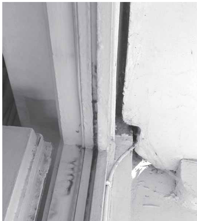
Felfüggesztett erkély nem megfelelő tűzállósági határértékű kapcsolata az épülethez
