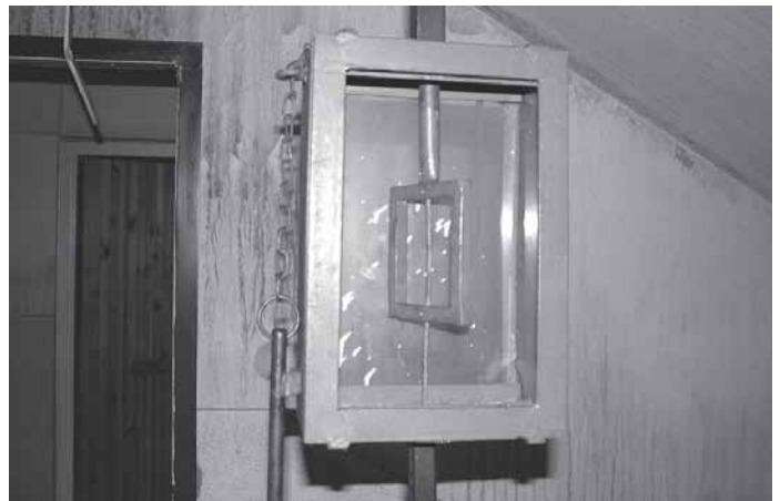
A füst elvezető nyitószerkezete nem működött
