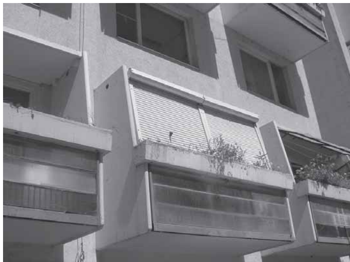
Felfüggesztett erkélyek egy szegedi LarsenNielsen rendszerű lakóépületnél, szabálytalan utólagos beépítéssel
