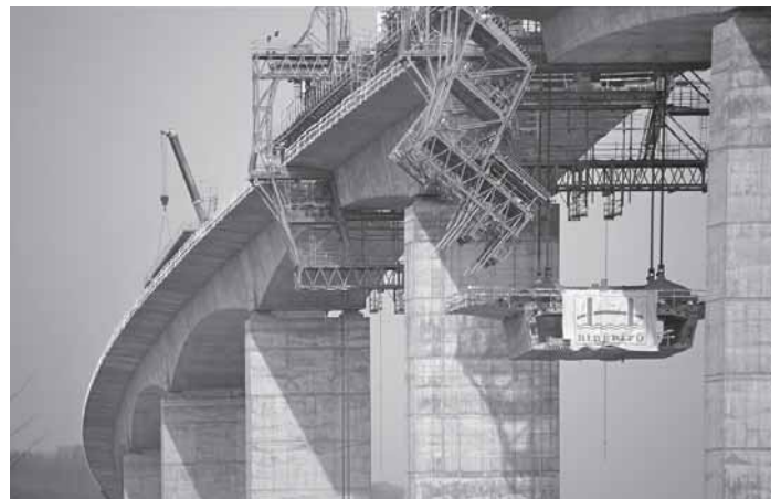
Az utolsó hídelem felemelése
