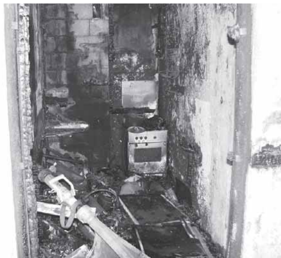
A budapesti VI. emeleti lakás konyhájának belső képe, az áthelyezett tűzhellyel (tűzkeletkezési hely). Megfigyelhető a gépészeti akna jó tűzállóságú Ytong falszerkezete és az eredeti szagelszívó csatlakozás
