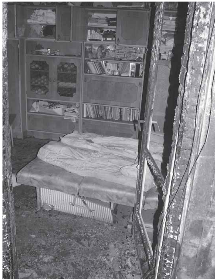
Teljes károsodás a lakásokban
