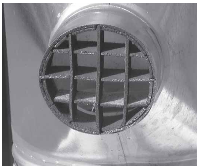
A szellőzőrács hő hatására lezár
