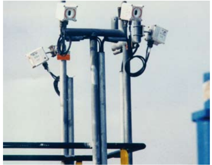
25. ábra. Oszlopon, döntve szerelt tripla-IR lángérzékelő
