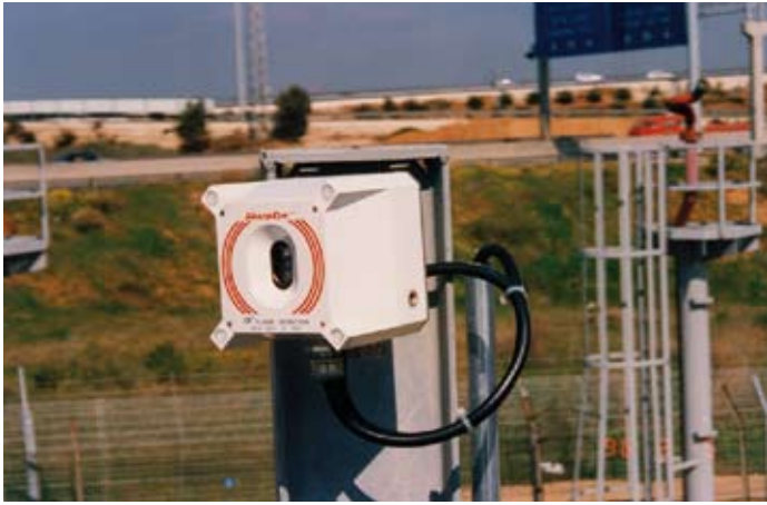
23. ábra. Tartályvédelemre alkalmazott tripla-IR lángérzékelő
