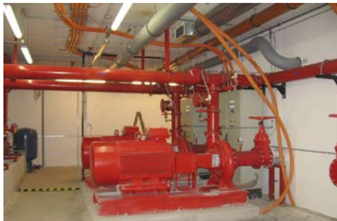
Két nagyteljesítményű szivattyú működteti a rendszert (alul)
