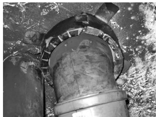
A védelem nélküli vezetékek (csatorna, víz, elektromos, stb.) további gyújtóforrást jelentenek
