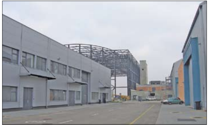
A műszaki kiszolgáló épületek és az épülő új stúdiócsarnok
