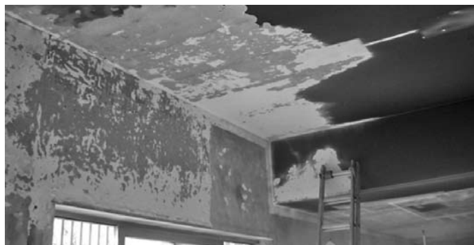
Falfelület koromlerakódásának tisztítása
