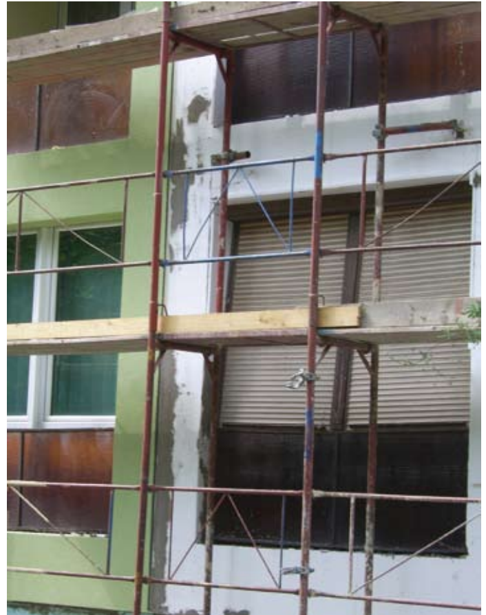
Az utólagosan szabálytalanul beépített loggiák között nincs meg az 1,3 méteres tűzvédelmi gát!
