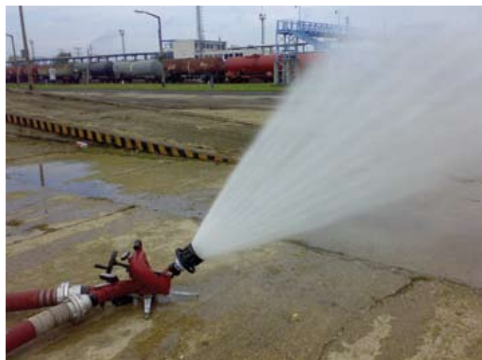
3. kép. Vector vízágyú által előállított szórt sugár
