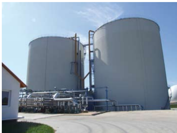
A két fermentor között a szivattyú és hőcserélő állomással és a gáztartály
