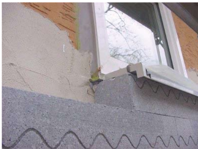
Vastag hőszigetelő rendszer alkalmazásakor, ha a nyílászáró nem a falszerkezetbe, hanem a hőszigetelő rendszerbe van beágyazva az veszélyes lehet
