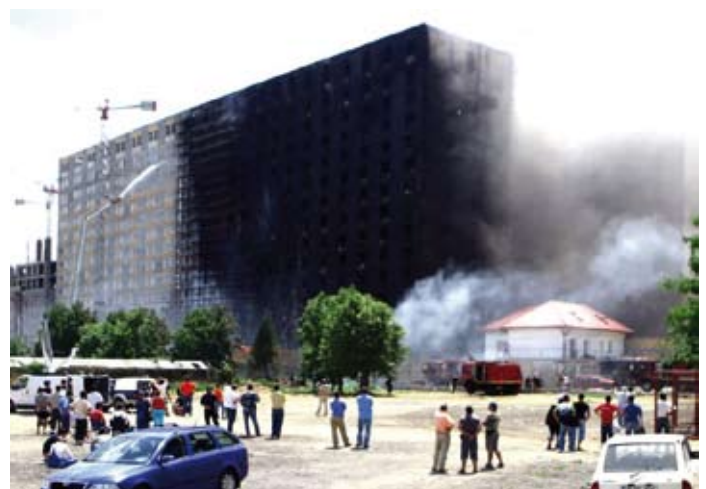
Építkezés: 15 perc alatt leégett a homlokzat
