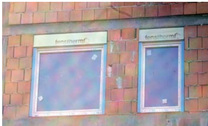
Áthidaló helyett tokmagasítás, épülettűznél jelentős kockázattal jár
