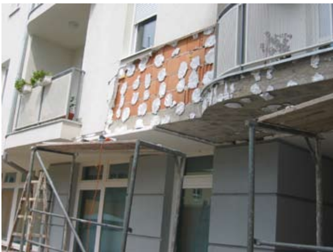
Gyenge dűbelezés, helytelen ragasztás – elégtelen védelem
