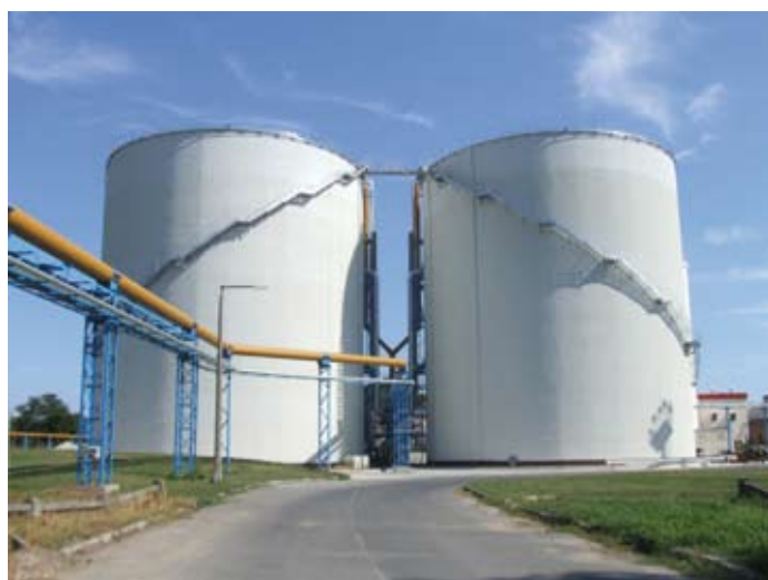
A két fermentor a biogáz vezetékkel
