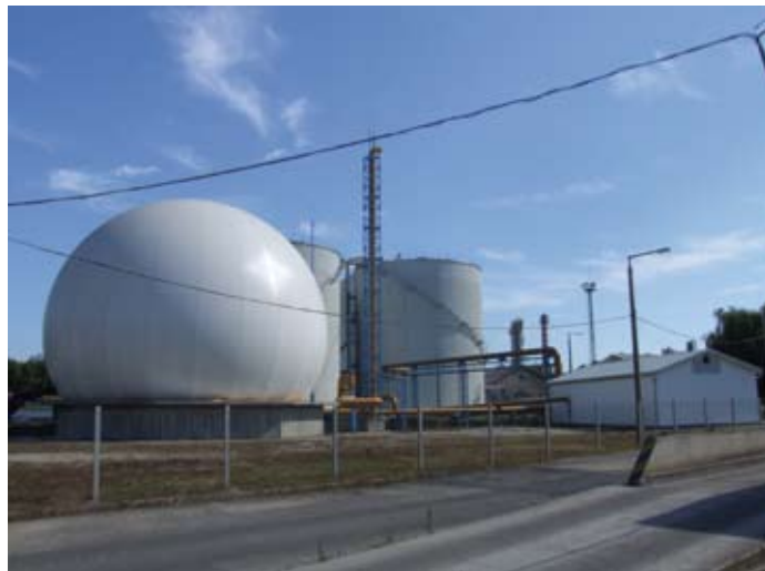
A duplamembrános gáztartály, a két fermentor, a kompresszorház, gázvezeték biztonsági szelepeinek lefúvó csöve a magasba vezetve.
