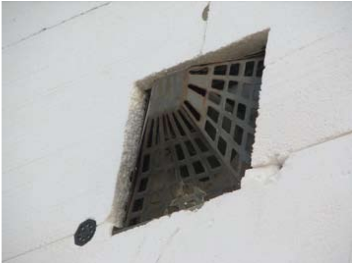
Parapet konvektorok égéstermék elvezetői szabálytalanul kialakítva
