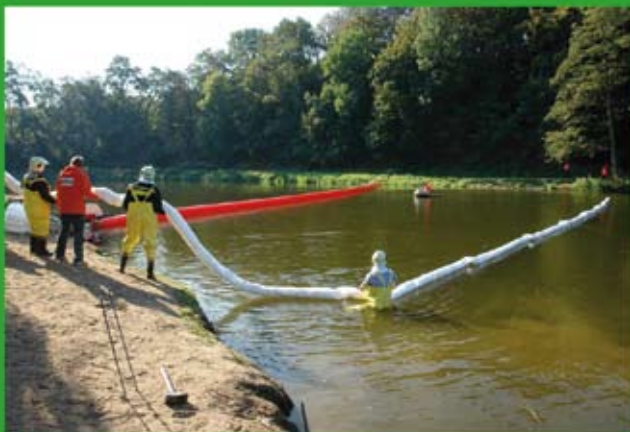
Élővízi kárelhárítás OBM olajszelektív úszó gátakkal
