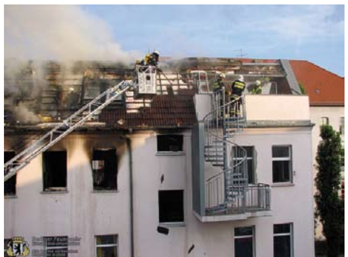
Éghető szigetelő anyag volt beépítve
