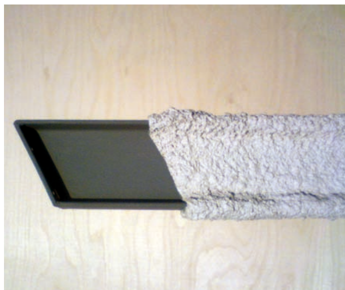
Szórt tűzvédelmi habarccsal 60 perc feletti tűzállóság érhető el
