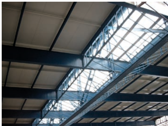
Hőre habosodó tűzvédő festékekkel max. 60 perces tűzállóságú védelem érhető el
