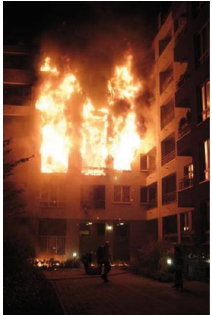
13. ábra. Tűzátterjedés homlokzaton
