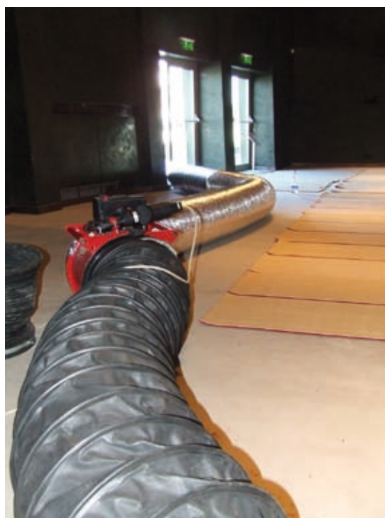
Ideiglenes, RB kivitelű szelőztető berendezés
