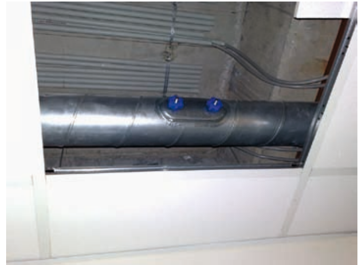
Az állapotfelmérés után tisztítónyílásokat építettek a vezetékekbe
