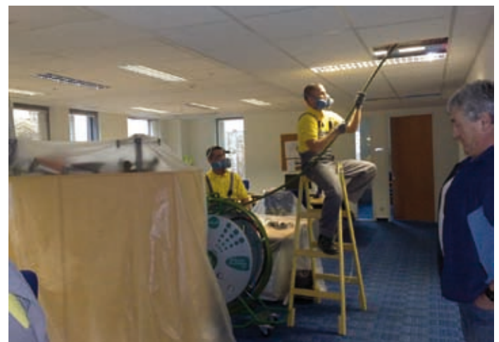
A tisztítófej bevezetése a vezetékszakaszba
