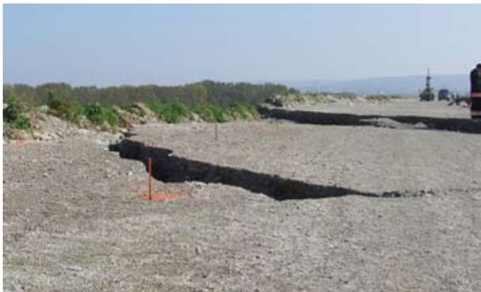
Repedések a gáton
