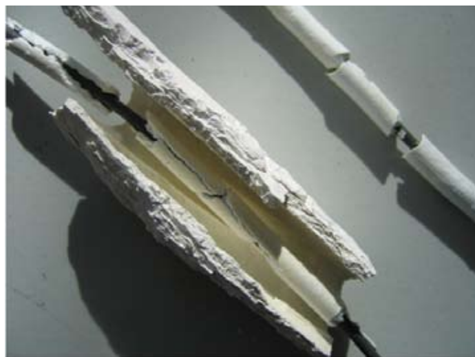
2.b ábra. Keramizálódó kábel állapota a tűzkitét után
