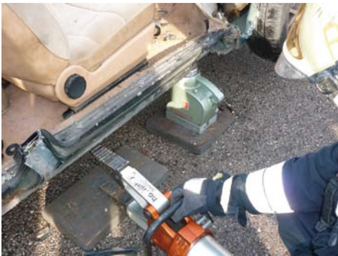
11. kép. Az emelő behelyezése és az előemelés
