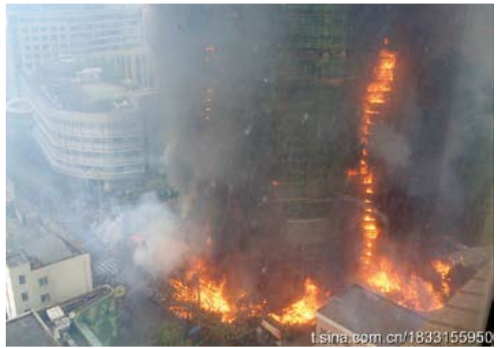
Az éghető hőszigetelő mindent lángtengerré változtatott
