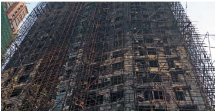
A 28 emeletes épület teljesen kiégett
