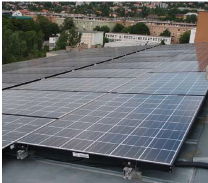
1. ábra. Tetőfödémre helyezett napelemek
