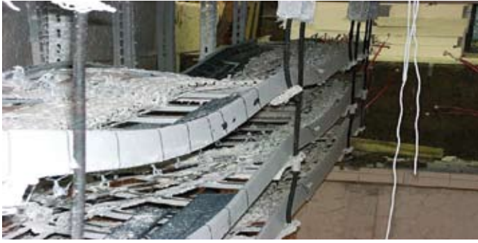
3. ábra. Kábeltartó-szerkezet hő hatására bekövetkezett deformációja (tűzálló kábelrendszer állapota a DIN 4102-12 vizsgálatot követően)
