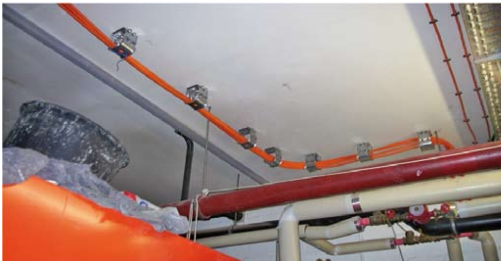
1. ábra. Szakszerűen kivitelezett tűzálló kábelrendszer
