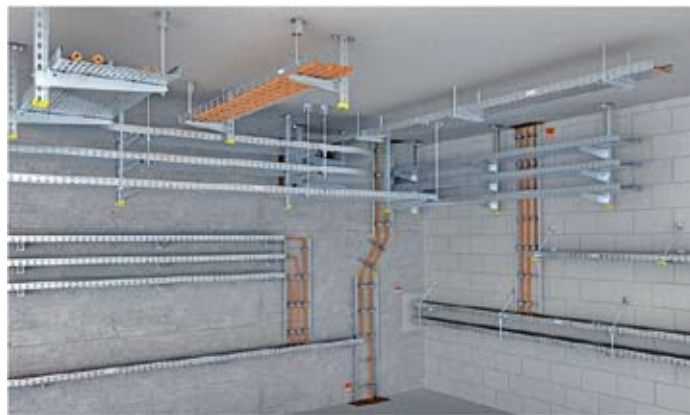
1. ábra. Különböző formában megvalósított integrált funkciótartású tűzálló kábelrendszerek
