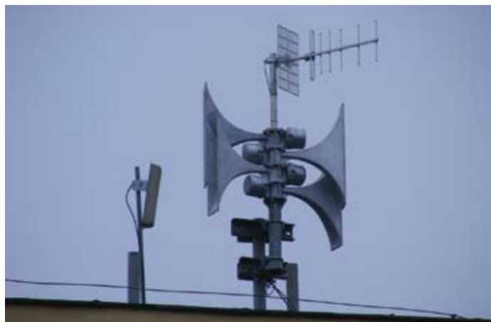
Lapos tetőn telepített riasztó végpont
