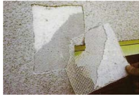
4. ábra. Ha az ablakszemöldöknél hiányzik a diagonális irányú erősítő hálóbétét
