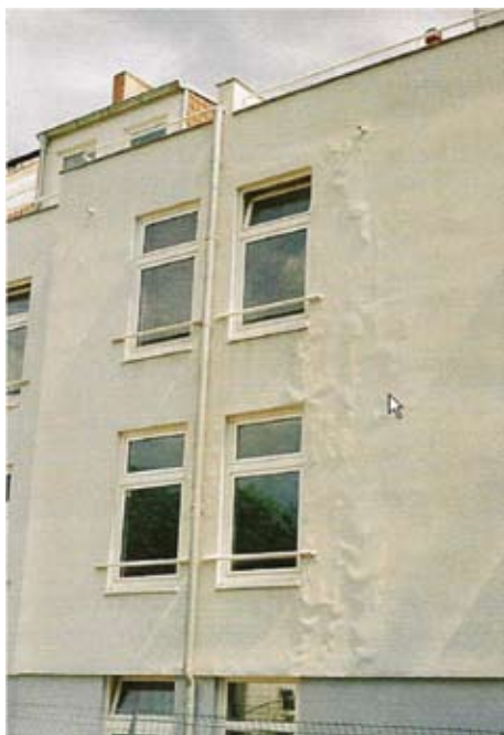
6. ábra. Pára és víz – helytelen kivitelezés
