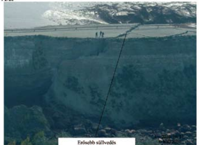
A gát középső szakaszán a legjelentősebb a süllyedés
