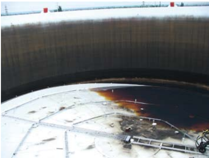
Részlegesen elsüllyedt úszótető
