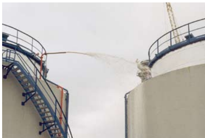
Habpróba tartályon (Forrás: Tűzör Kft.)
