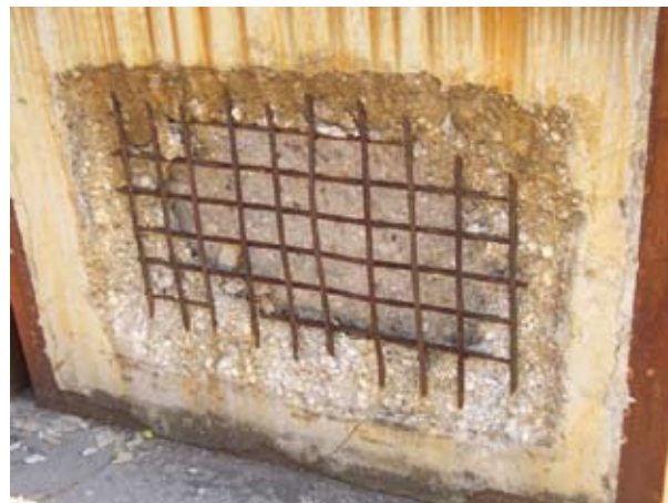
2. ábra. Vasbeton károsodása
