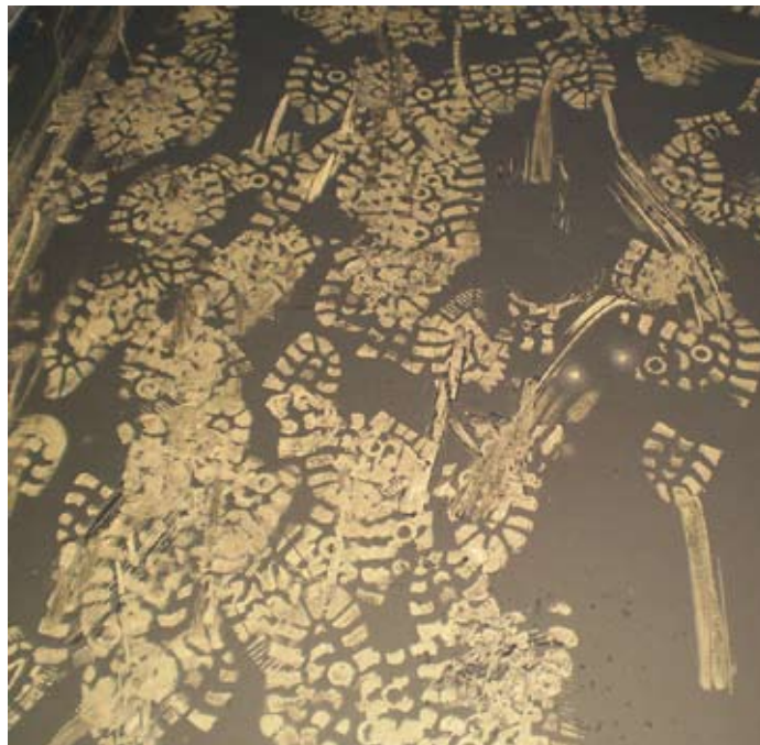
Csendes gyilkos – sűrű koromlerakódás a tűztől távoli terekben
