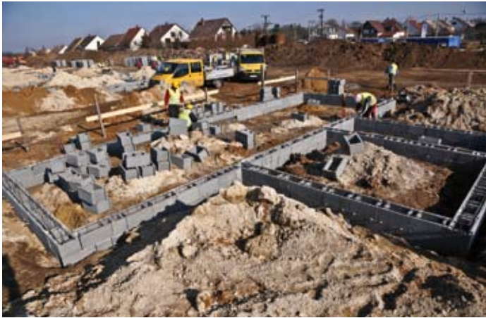
Bontás után építés
