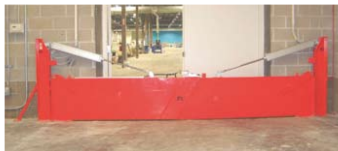
2. ábra. Automatikusan vezérelt oltóvíz-zár
