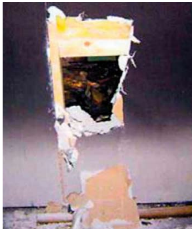
6. kép. Tűzterjedési nyomok a gipszkarton burkolat mögött, amelyek csak a burkolat megbontásával láthatóak
