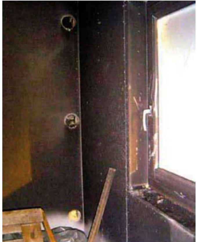
9. kép. Homlokzati fal belső részlete a tűz után
