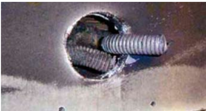
8. kép. Elektromos dugalj közelképe. Jól látható, hogy a dugalj mögött nincs ún. tűzvédelmi doboz, amely a gipszkarton lemez megszakításánál megakadályozná a tűzterjedést
