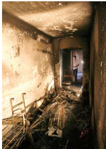
Kiegészített menekülési útvonal – 15 lakót kellett kimenteni
