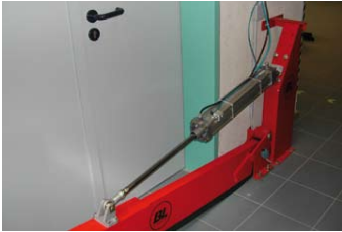
3. ábra. Automatikus vezérelt oltóvíz-zár működés közben
