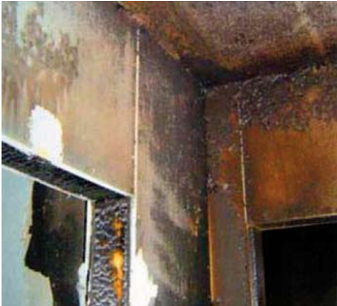
7. kép. Szobasarak részlete a tűz után. Jól látható a falnyílások körüli faszervezet elszenesedése
