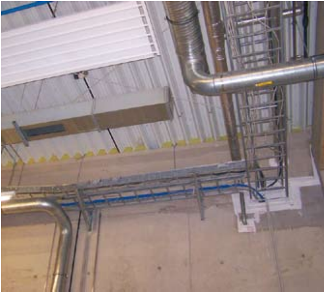
Nagy térfogattömegű kőzetgyapot tűzgátló tömítésként
