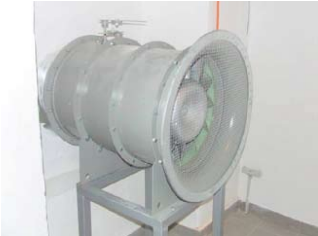
Füstelszívó ventilátor a magtárépület végfalánál
