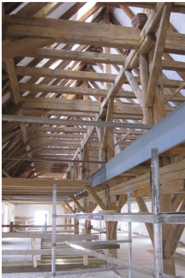
Faszerkezetek építés közben
