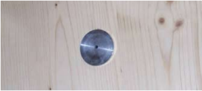
Aspirációs füstérzékelő szívónyílása a fafödémbe
