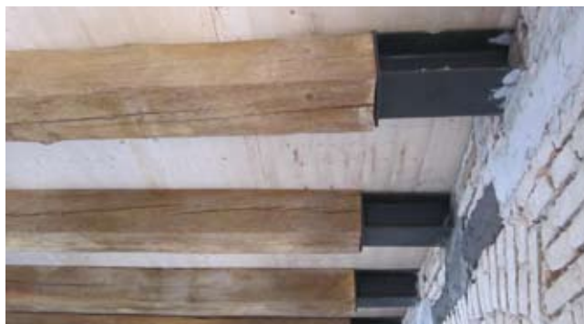
A gerendázat megmentése I tartókkal
