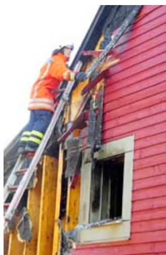
5-6 sz. képek. A freiburgi könnyűszerkezetes óvoda tüzeseti képein jól látszik a légrésekben terjedő tűz
