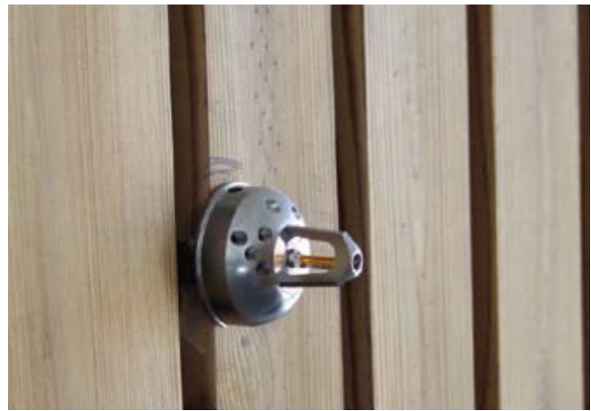
Vízköddel oltó szórófej az új épületrészben
