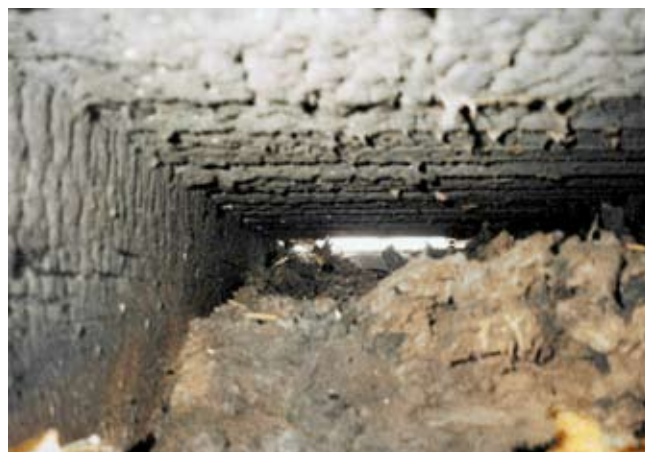
8 sz. ábra. Tűzterjedés nyomai üvegyapot szigetelőanyag és faszervezet által határolt légrésekben
