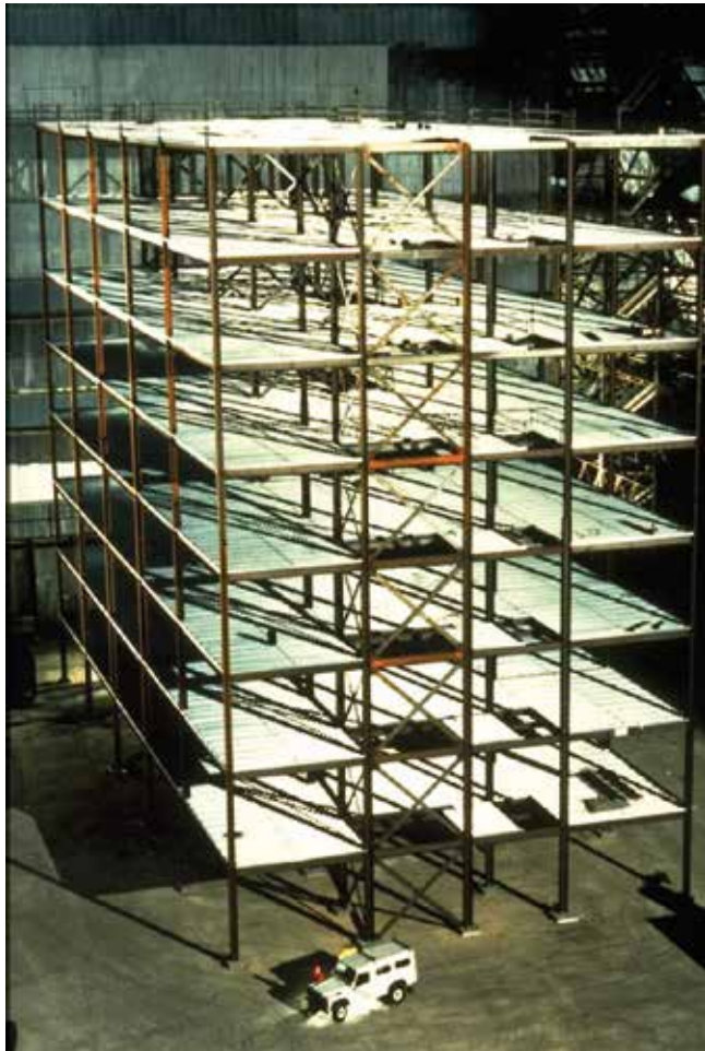
1. ábra. Cardington teszt-épület a födémelek betonozása előtt
