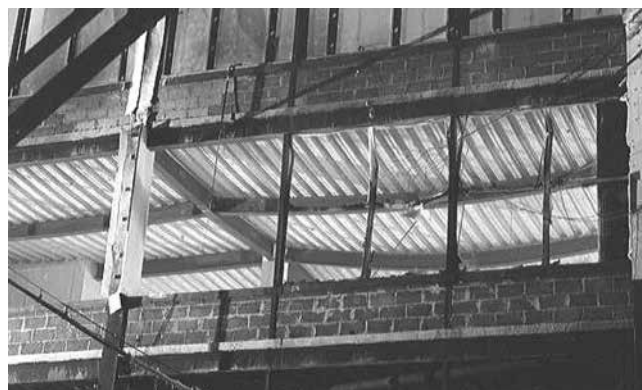
12. ábra. Alakváltozott szerkezet a tűz folyamán
