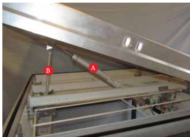
II/I. FÜSTELVEZETÉS: MUNKAHENGER, CO 2 (A) SZELLŐZTETÉS: ELEKTROMOS MOTOR, 230V (B)
