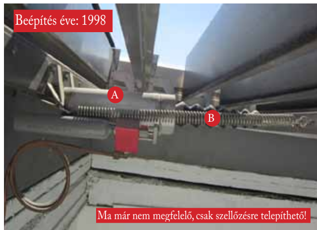
II/4. FÜSTELV. ÉS SZELLŐZTETÉS: AZONOS MUNKAHENGER, SŰRÍTETT LEVEGŐ (A); NYOMÁS ELVÉTELEKOR MINDKÉT FUNKCIONÁL RUGÓ (B) ZÁR; MÁR NEM ALKALMAZHATÓ
