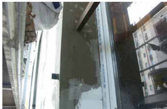
A KÜLSŐ HOMLOKZATI HŐSZIGETELŐ RENDSZER
