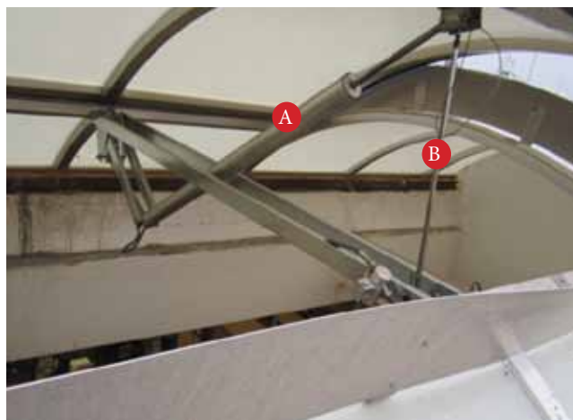
II/2. FÜSTELVEZETÉS: MUNKAHENGER, CO 2 (A) SZELLŐZTETÉS: SŰRÍTETT LEVEGŐ KÜLÖN MUNKAHENGER (B)
