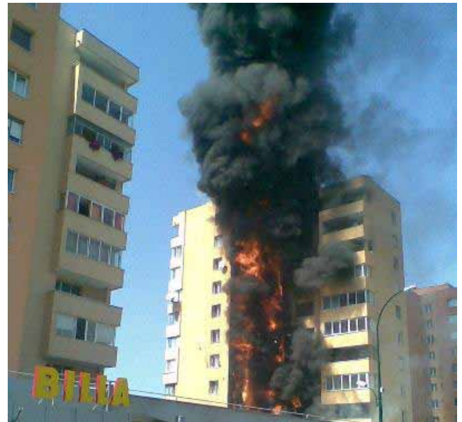
SZABÁLYTALAN TÁROLÁS – ÉG A HOMLOKZAT
