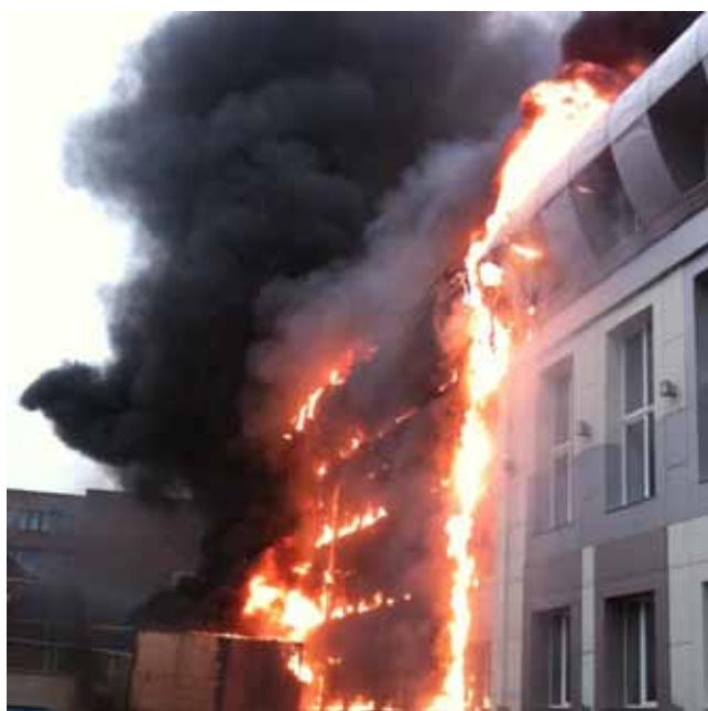
LÁNGOLÓ LAKÓHÁZI HOMLOKZAT
