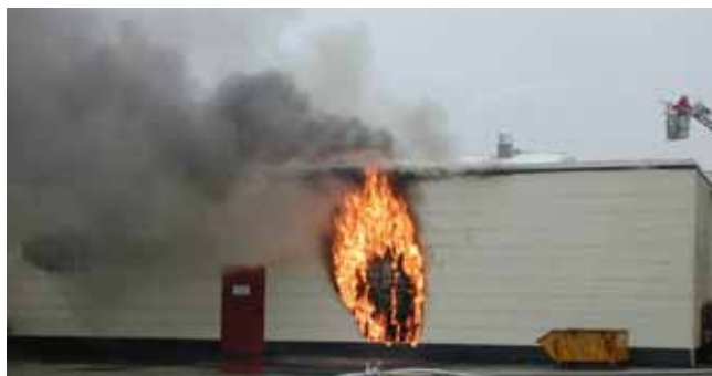
CSARNOKÉPÜLET HŐSZIGETELÉSE ÉG
