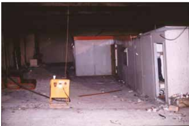
TŰZTÉR FELETTI DEFORMÁLÓDOTT FÖDÉM (MAXIMÁLIS LEHAJLÁS: 600 MM)
