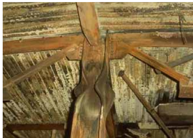
BROADGATE: HORPADT OSZLOP, DEFORMÁLÓDOTT GERENDA
