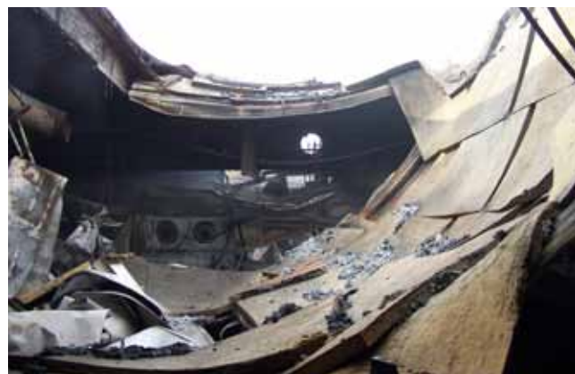
A BEOMLOTT TETŐSZERKEZET
