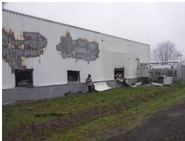
ERŐS HŐHATÁS JELEI AZ OLDALPANELEKEN
