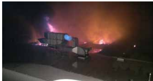
TÖBB HELYEN BESZAKADT A KŐZETGYAPOTTAL HŐSZIGETELT TETŐPANEL TETŐSZERKEZET
