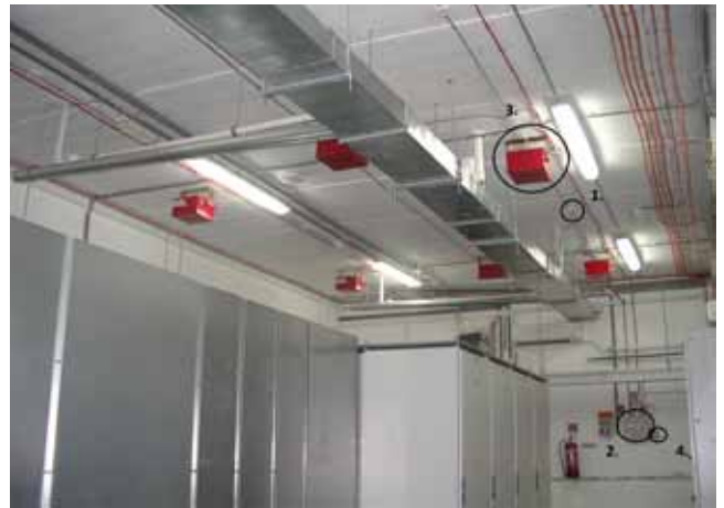
REHAU-0,4 KV-OS ELEKTROMOS HELYSÉG
