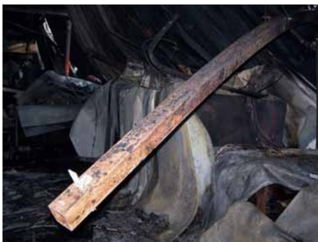
A TŰZ KELETKEZÉSI HELYE, A TŰZESETET OKOZÓ GÉPRE OMLOTT TETŐSZERKEZET
