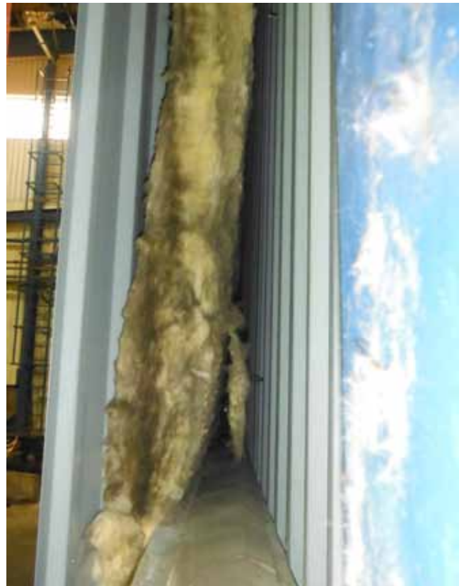
A SZENDVICSSZERKEZETŰ VÁLASZFAL KIALAKÍTÁSA
