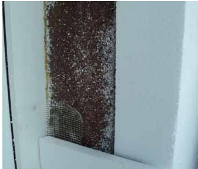
A béllet szigetelés és a nyílászáró tokszerkezete közt vezetett erősítő háló nincs ragasztórétegre ágyazva, így ez a kialakítás tűzvédelmileg nem megfelelő
