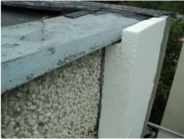
A polisztirol tábla elhelyezése előtt nem került fel az alapfelületre ragasztórétegbe ágyazott erősítő háló
