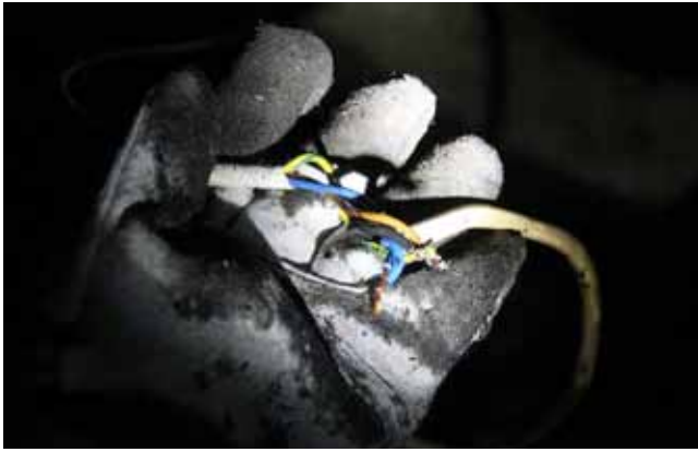
NEM SZABVÁNYOS VILLANSZERELÉSI KÖTÉSEK
