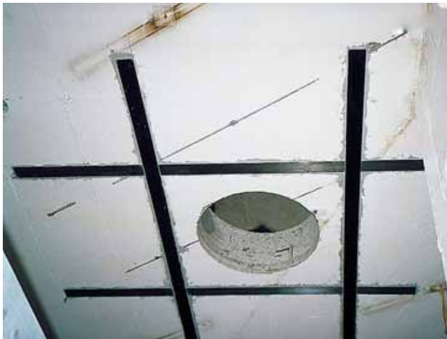
JAVÍTÁS SZÉNSZÁLAS SZERKEZETERŐSÍTŐ CSÍKKAL
