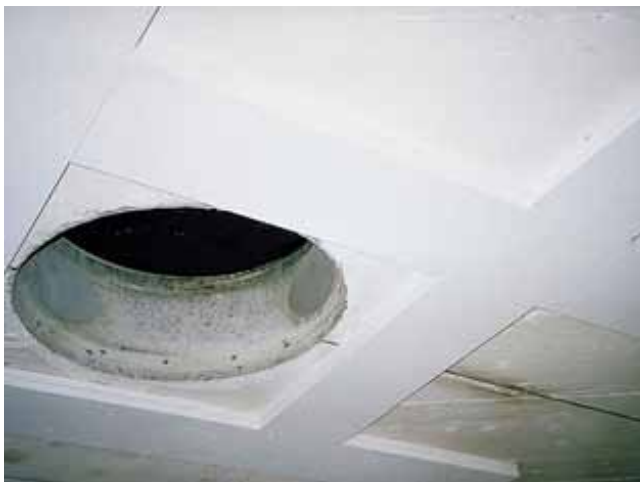
JAVÍTÁS SZÉNSZÁLAS SZERKEZETERŐSÍTŐ CSÍKKAL
