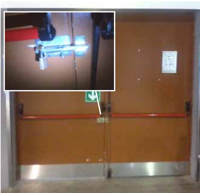
III. ÁBRA: PÁNIKRÚDDAL ELLÁTOTT AJTÓN FELSZERELT RETESZ
