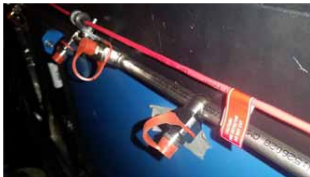
A LINEÁRIS ÉRZÉKELŐ KÁBEL 180 °C-NÁL INDÍT
