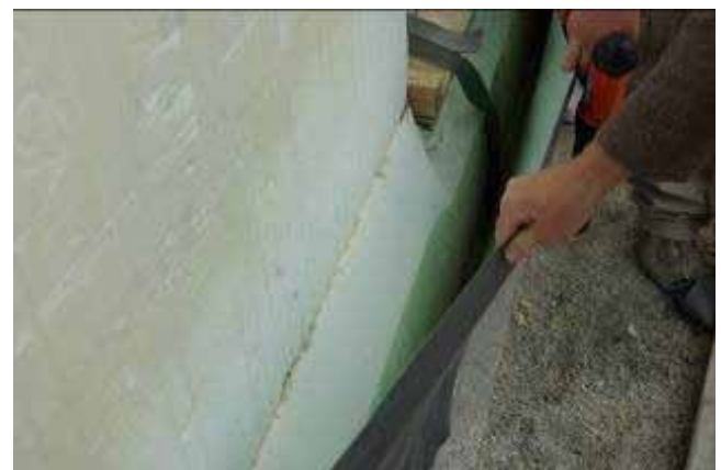
ALACSONY ENERGIAIGÉNYŰ ÉPÜLET LÁBAZATI SZIGETELÉSE (FOTÓ: TÓTH PÉTER)
