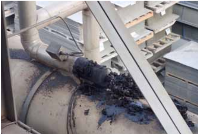
GRECON OLTÓFEJ ÉGETT ÁLLAPOTBAN (SZIKRAÉRZÉKELŐ ÉS OLTÓBERENDEZÉS)
