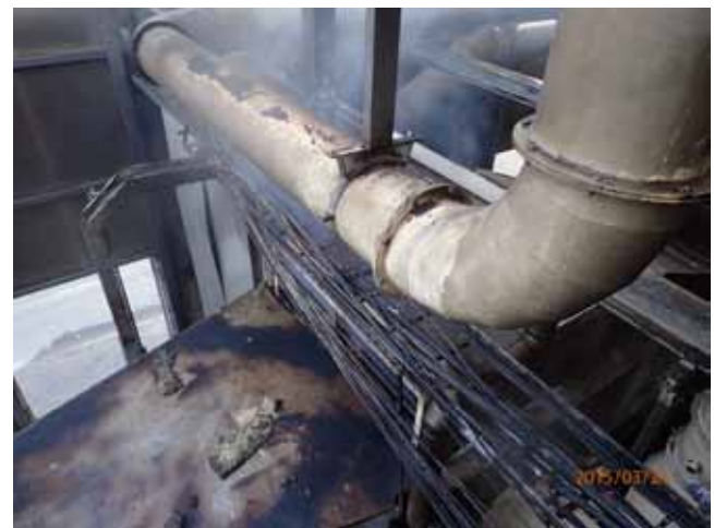
KÁBELEK SÉRÜLÉSEI (SZIKRAÉRZÉKELŐT ÉS OLTÓRENDSZERT IS SZABÁLYOZOTT)
