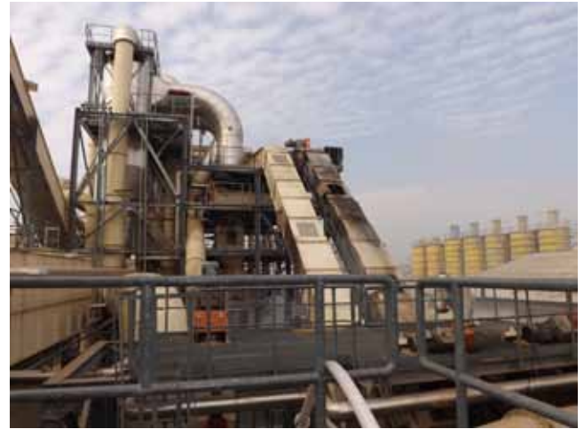
SZÁLLÍTÓSZALAG LEMEBZURKOLATAI A ROBBANÁS UTÁN
