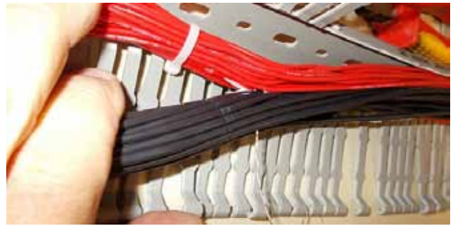
A PVC SZIGETELÉSE A HŐ HATÁSÁRA MEGOLVADT
