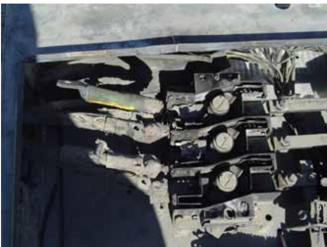
A LAZA KÖTÉSEK OKOZTA MEGHIBÁSODÁS KÉPE
