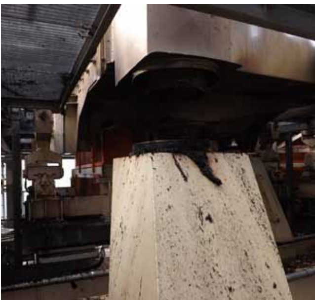
SZITÁK ALATTI TÉR ÉGÉSNYOMAI
