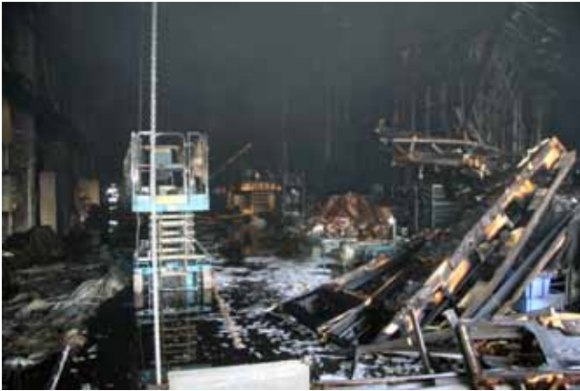
NEM OLTOTTA EL A BEÉPÍTETT OLTÓBERENDEZÉS
