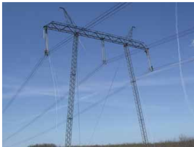
400 KV-OS VILLAMOS VEZETÉK
