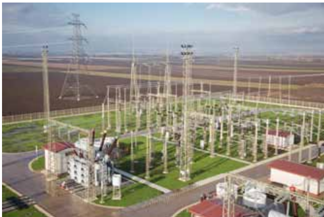
33 NAGYFESZÜLTSGŰ TRANSZFORMÁTOR ALÁLLOMÁS
