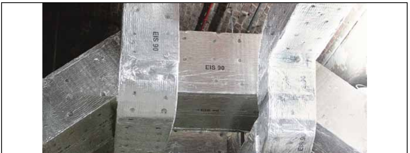
HFR LÉGCSATORNA SZABÁLYOS KIALAKÍTÁSA
