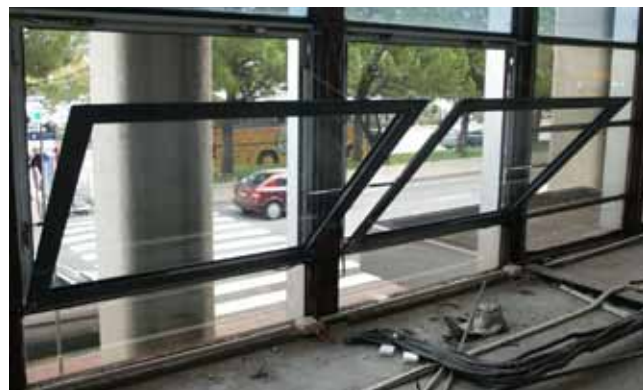
EXUBAIE – NYÍLÓSÁRNYAS, TOKOZATBA REJTETT MŰKÖDTETŐ SZERKEZETES FÜSTELVEZETŐ ÉS LÉGPÓTLÓ ABLAK
