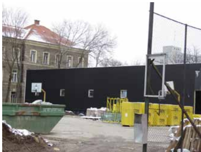
ÉPÜLET NŐTT A KIJELÖLT GYÜLEKEZÉSI HELYRE
