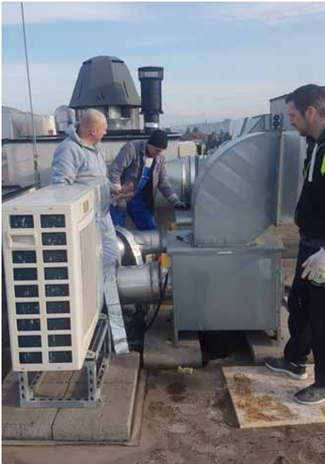
A TETŐN LÉVŐ BERENDEZÉSEK
